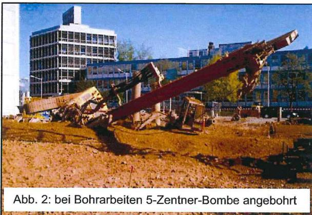
Abb. 2: bei Bohrarbeiten 5-Zentner-Bombe angebohrt
