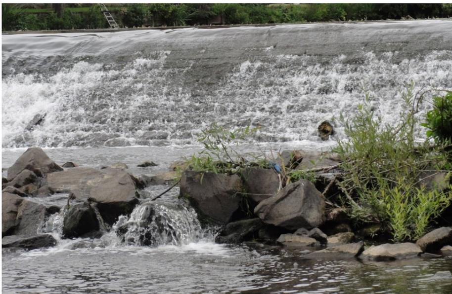
**Abbildung 14:** Sturzbettsicherung aus Wasserbausteinen
