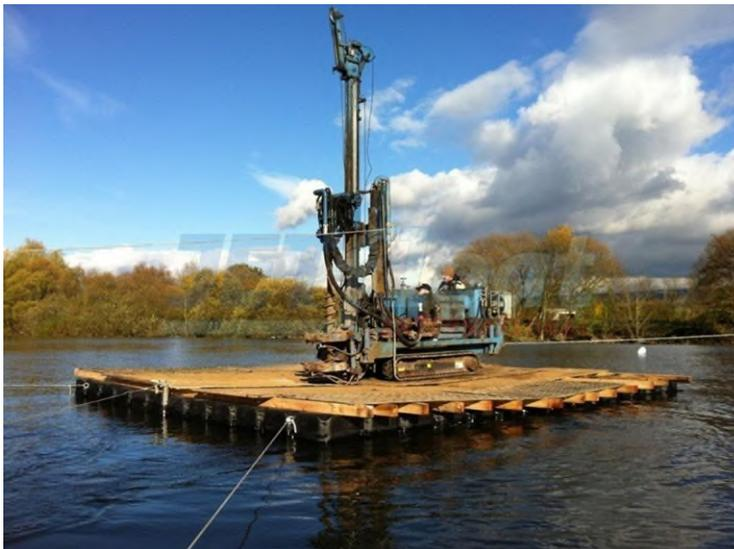
**Bild 3:** Bohrgerät auf Ponton; Quelle: [www.duwe.de](http://www.duwe.de)
