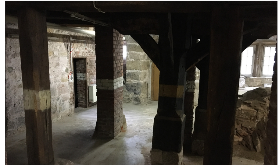
STÜTZEN IM WESTLICHEN BEREICH
