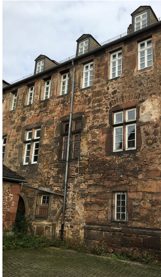
ZUGEMAUERTE ÖFFNUNGEN
