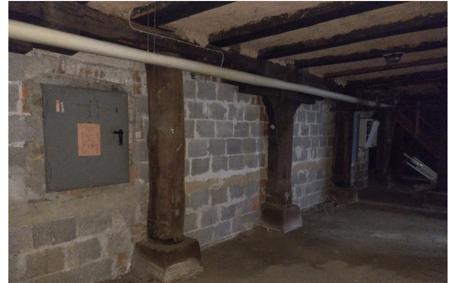
MAUER ZUM ÖLTANK IM TALGESCHOSS
