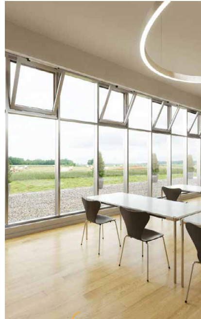
Die Nachtlüftung ist eine gleichermaßen simple und effektive Form der Gebäudekühlung. In Nicht-Wohngebäuden werden dafür am besten automatisch öffnende Nachtlüftklappen eingesetzt, die auch über einen Einbruchschutz verfügen müssen.
