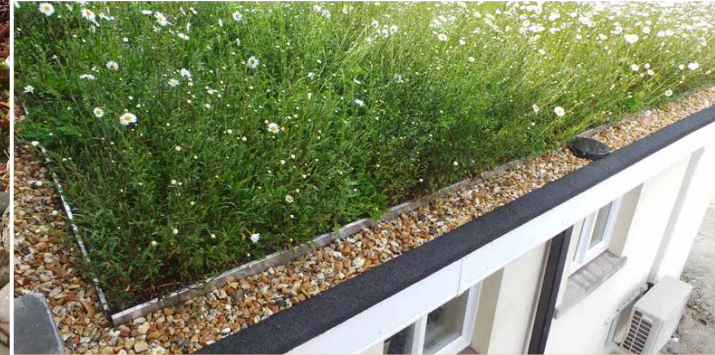
Gründächer verbessern nicht nur das Mikroklima, sondern können auch attraktive grüne Rückzugsräume in der Stadt darstellen (oben rechts). In Kombination mit Retentionselemente können zusätzlich Synergien mit der Starkregenvorsorge und Regenwasserwirtschaft erzeugt werden (unten).
