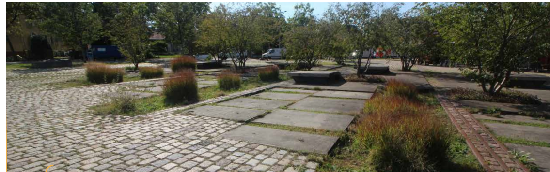
Multifunktionale Retentionsflächen, wie der Bellamyplein in Rotterdam (oben links und rechts) ermöglichen es innerstädtische Flächenkonkurrenzen zu vermeiden. Auch der Zollhallenplatz in Freiburg im Breisgau (unten) ermöglicht die Retention von Niederschlägen im Falle eines außergewöhnlichen Starkregens und steht sonst als Stadt- oder Marktplatz anderen Nutzungen zur Verfügung.
