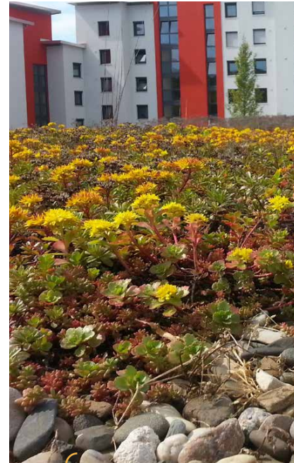
Gründächer verbessern nicht nur das Mikroklima, sondern können auch attraktive grüne Rückzugsräume in der Stadt darstellen (oben rechts). In Kombination mit Retentionselemente können zusätzlich Synergien mit der Starkregenvorsorge und Regenwasserwirtschaft erzeugt werden (unten).
