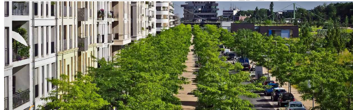
Stadtbäume verbessern das Mikroklima und werten das Stadtbild optisch auf. Für klimagerechte Baumstandorte bedarf es einer sorgfältigen Vorbereitung des Untergrundes (z.B. durch Einsatz einer Baumrigole) und angepassten Baumscheiben (oben links).
