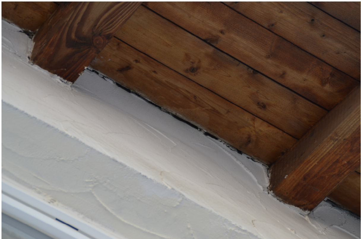
Abb. 4: Bürogebäude, Dachüberstand an der Längsseite des Gebäudes.
