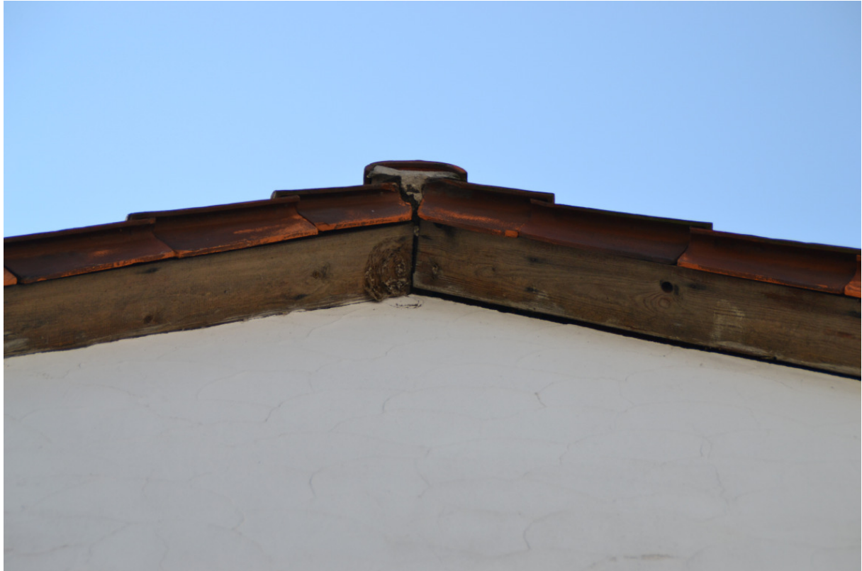
Abb. 5: Bürogebäude, Dachüberstand Giebel.
