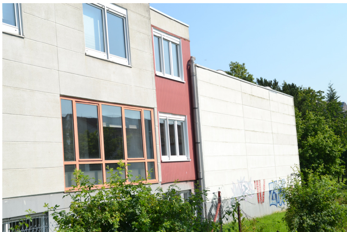
Abb. 6,7: Südseite des östlichen Gebäudes.
