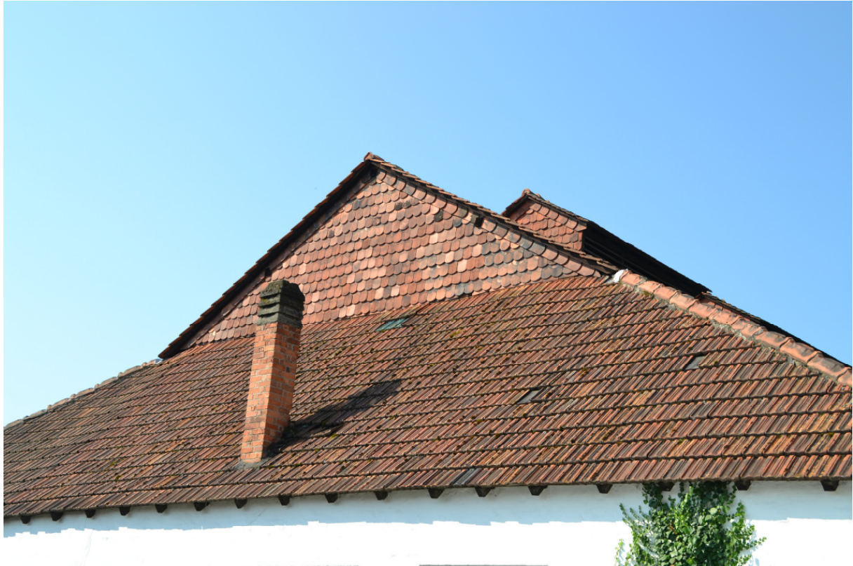
Abb. 3: Ringofengebäude, Giebelverkleidung mit Bieberschwänzen.
