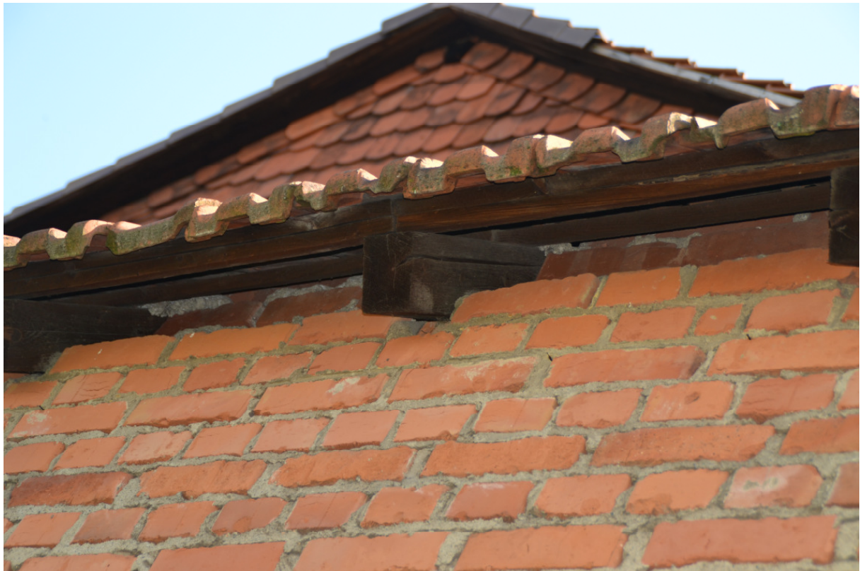
Abb. 1: Ringofengebäude, Mauerwerk unter dem Dachüberstand.
