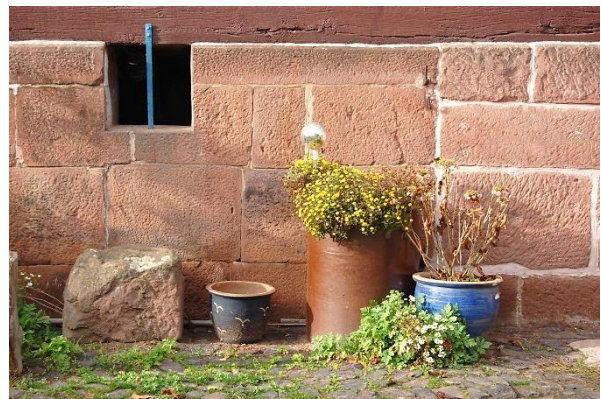
Abb. 7: Sandsteinsockel des Fachwerkgebäudes in der Bauerbacher Straße 17; Quelle: Eigene Aufnahme
