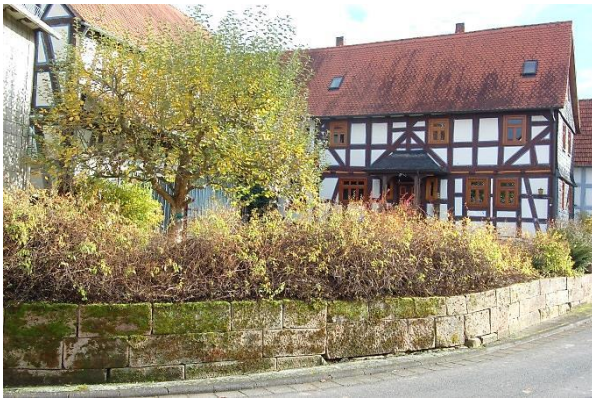
Abb. 10: Hofanlage in der Bodenfeldstraße mit dörflicher Gartengestaltung; Quelle: Eigene Aufnahme
