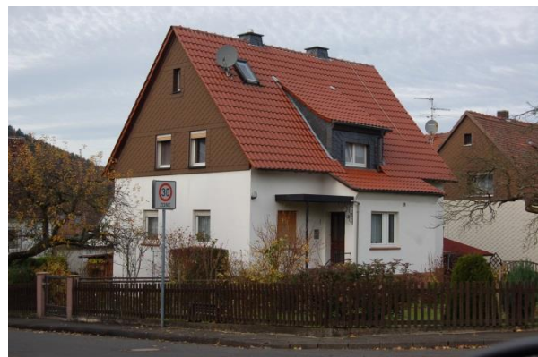
Abb. 54: Siedlungshaus der 1950er-Jahre in der Straße Am Schulgarten ; Quelle: Eigene Aufnahme
