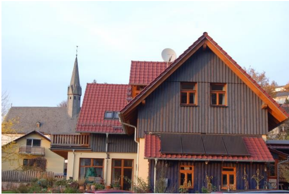
Abb. 148: Farbiger Putz und Holzschalung; Quelle: Eigene Aufnahme
