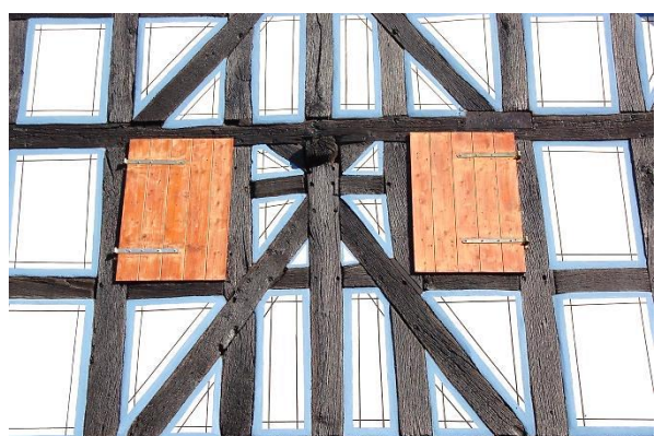
Abb. 13: Detail des Fachwerks des Vierseithofes in der Bodenfeldstraße ; Quelle: Eigene Aufnahme
