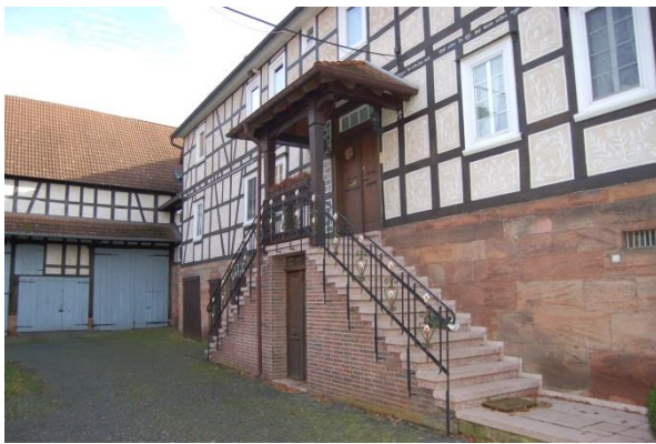
Abb. 156: Vordach über Hauseingang mit zweiläufiger Treppenanlage; Quelle: Eigene Aufnahme
