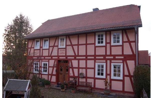
Abb. 110: Fachwerkwohnhaus im Kirchgraben 1 ; Quelle: Eigene Aufnahme
