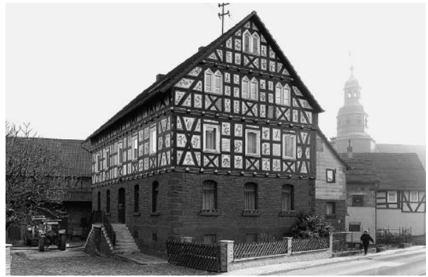
Abb. 102: Fachwerkwohnhaus in der Schröcker Straße 9 ; Quelle: Denkmaltopografie Stadt Marburg II
