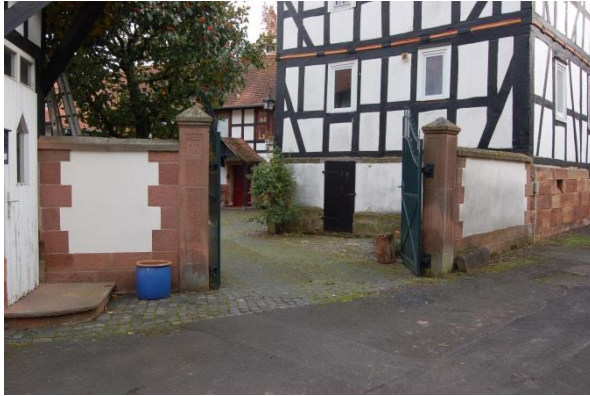
Abb. 170: Toreinfahrt zu einer Hofanlage; Quelle: Eigene Aufnahme
