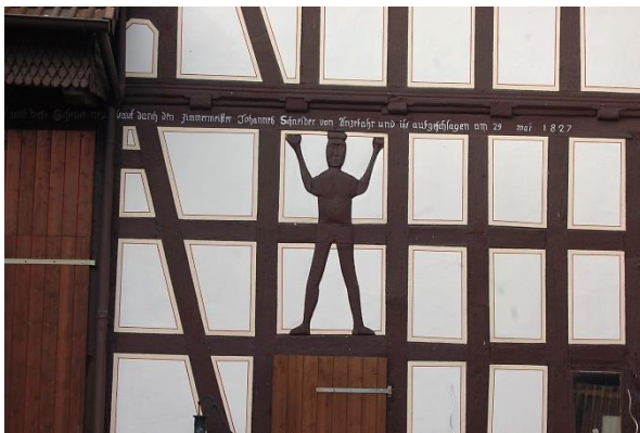
Abb. 6: Außergewöhnliche Ausprägung eines „Wilden Mannes“ an der Hofanlage Lohgasse 3; Quelle: Eigene Aufnahme
