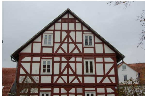
Abb. 133: Geringer Dachüberstand an Ortgang und Traufe; Quelle: Eigene Aufnahme
