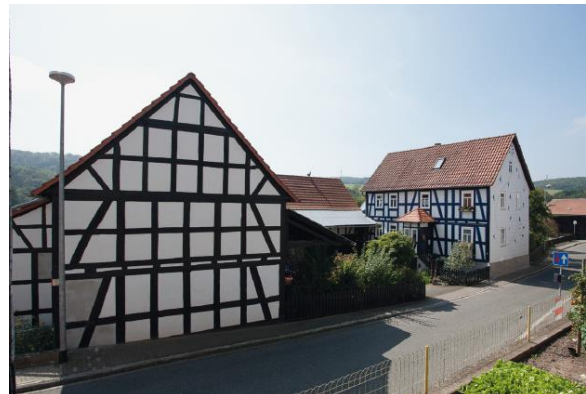
Abb. 65: Hof in der Haddamshäuser Straße 29/31 (Kulturdenkmal); Quelle: Denkmaltopografie Stadt Marburg II
