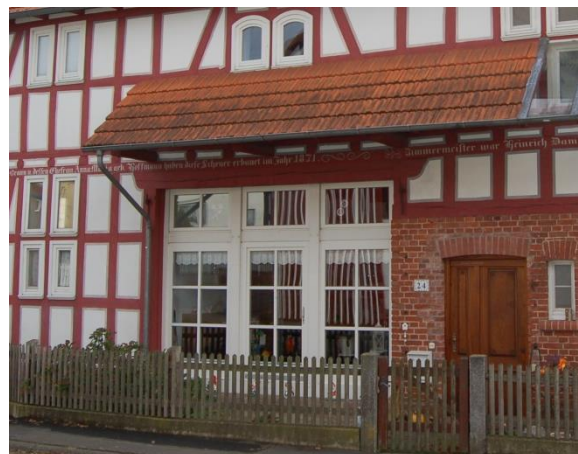
Abb. 155: Fensterelement in ehem. Toreinfahrt; Quelle: Eigene Aufnahme
