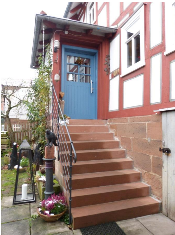
Abb. 162: Neue Haustür und neues Treppengeländer; Quelle: FD Stadtplanung und Denkmalschutz
