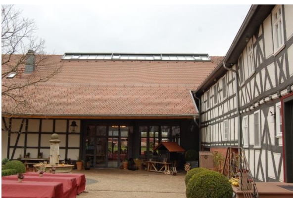
Abb. 26: Hofansicht der Kultur- und Eventscheune; Quelle: Eigene Aufnahme
