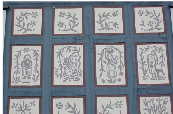
Abb. 139: Gefache mit Kratzputz; Quelle: Eigene Aufnahme
