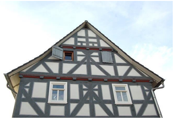
Abb. 90: Fachwerk einer Hofanlage in der Wittelsberger Straße 6; Quelle: Eigene Aufnahme
