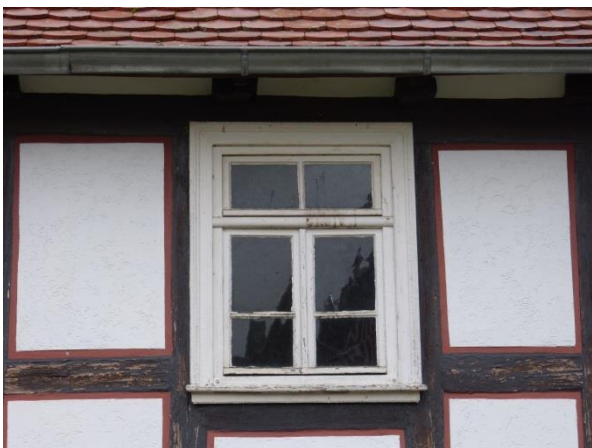
Abb. 154: Historisches Holzfenster mit glasteilenden Sprossen; Quelle: FD Stadtplanung und Denkmalschutz
