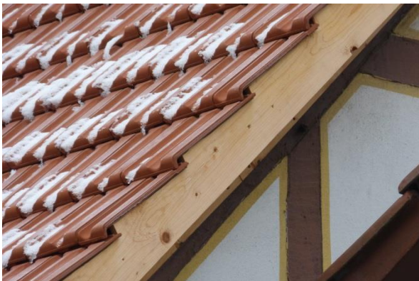
Abb. 132: Ortgang mit Zahnleiste; Quelle: FD Stadtplanung und Denkmalschutz
