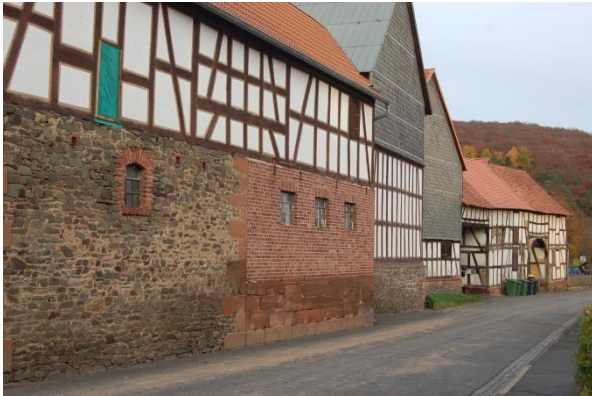
Abb. 34: Blick entlang der Scheunen in der Straße Bubenmühle; Quelle: Eigene Aufnahme
