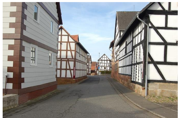
Abb. 94: Blick in die Hintergasse ; Quelle: Eigene Aufnahme
