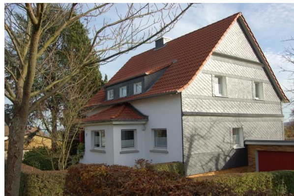
Abb. 131: Satteldach eines Siedlungshauses zeigt die typische Dachneigung ; Quelle: Eigene Aufnahme
