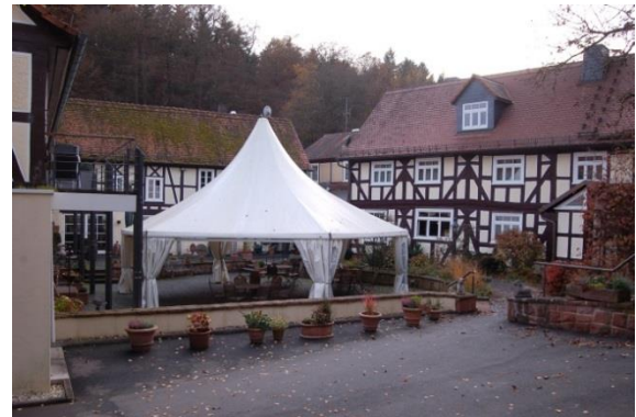
Abb. 120: ehemalige Damm-Mühle mit Teich; Quelle: Eigene Aufnahme
