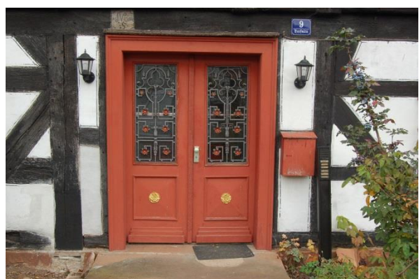
Abb. 60: Haustür des Fachwerkhouses in der Dorfmitte 9 ; Quelle: Eigene Aufnahme
