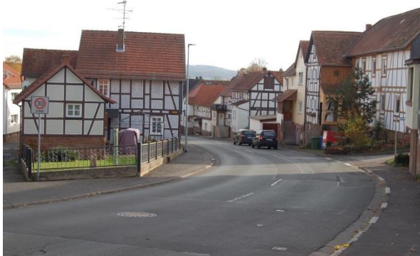
Abb. 128: Satteldächer prägen die Straßenbilder; Quelle: Eigene Aufnahme
