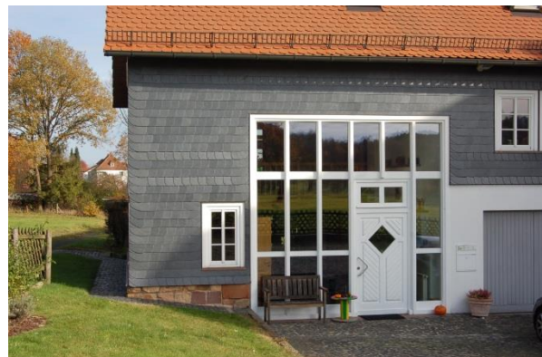
Abb. 153: Moderne Fenstergestaltung an ausgebautem Nebengebäude; Quelle: Eigene Aufnahme
