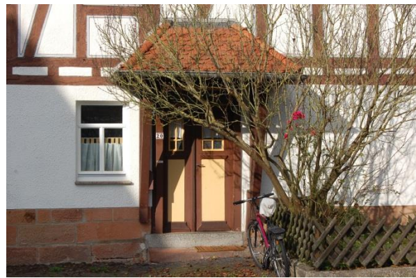
Abb. 157: Walmdach in Holzkonstruktion; Quelle: Eigene Aufnahme
