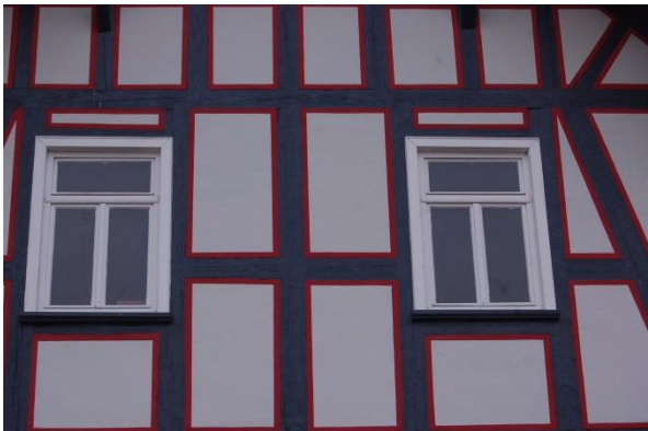
Abb. 38: Fachwerk einer Hofanlage im Unterdorf; Quelle: Eigene Aufnahme
