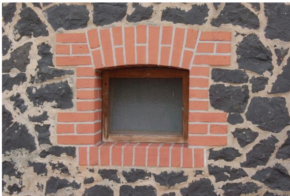
Abb. 144: Basaltsockel mit eingefasstem Fenster mit Ziegeln; Quelle: Eigene Aufnahme
