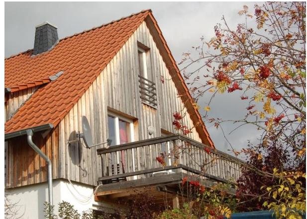
Abb. 167: Balkon; Quelle: Eigene Aufnahme
