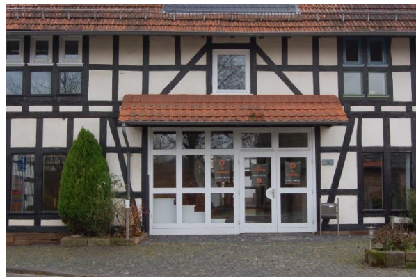
Abb. 159: Neues Vordach über Türelement; Quelle: Eigene Aufnahme
