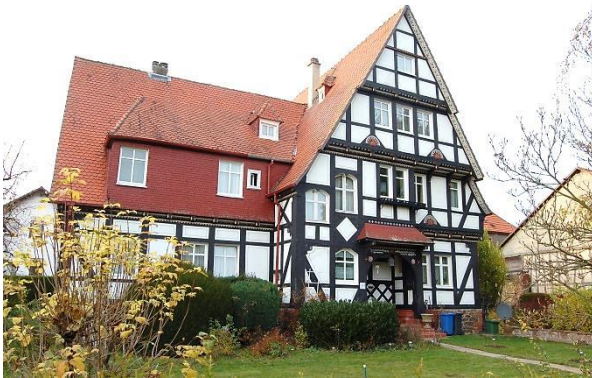
Abb. 43: Ehemaliges Pfarrhaus in der Straße Am Denkmal (Kulturdenkmal); Quelle: Eigene Aufnahme
