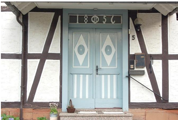
Abb. 45: Detailreiche Eingangstür in der Hofanlage Johannesgasse 5 (Gesamtanlage); Quelle: Eigene Aufnahme
