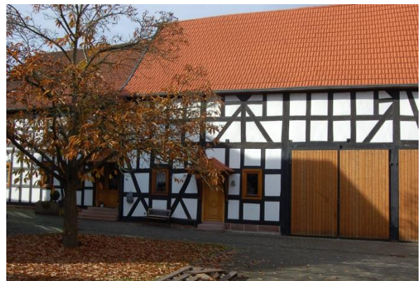
Abb. 163: Tor an Nebengebäude; Quelle: Eigene Aufnahme
