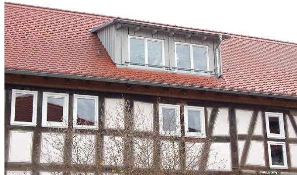
Abb. 52: Schleppgaube an einem sanierten Fachwerkhaus; Quelle: Eigene Aufnahme
