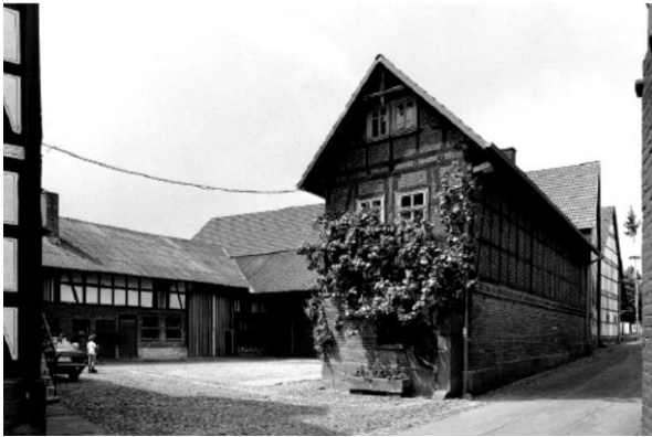
Abb. 4: Ehemaliger Deutschordenhof im Kirchweg 3; Quelle: Denkmaltopografie Stadt Marburg II
