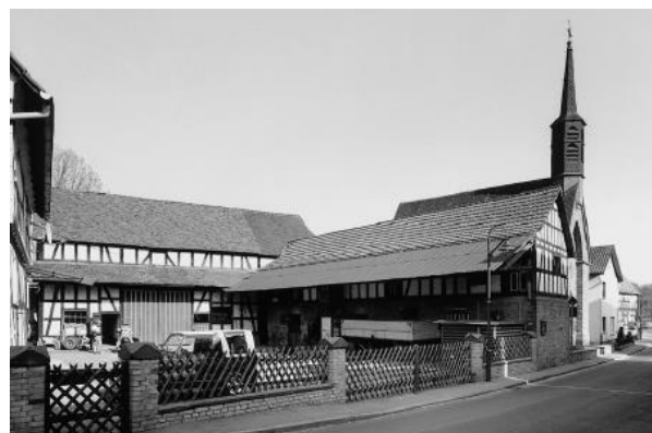
Abb. 73: Ehemaliger Lehenshof in der Hermershäuser Straße 1 ; Quelle: Denkmaltopografie Stadt Marburg II
