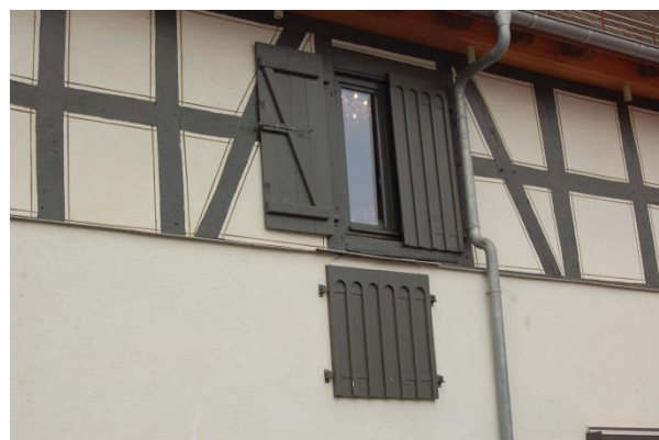
Abb. 27: Fassaden- und Fenstergestaltung an der Kultur- und Eventscheune; Quelle: Eigene Aufnahme
