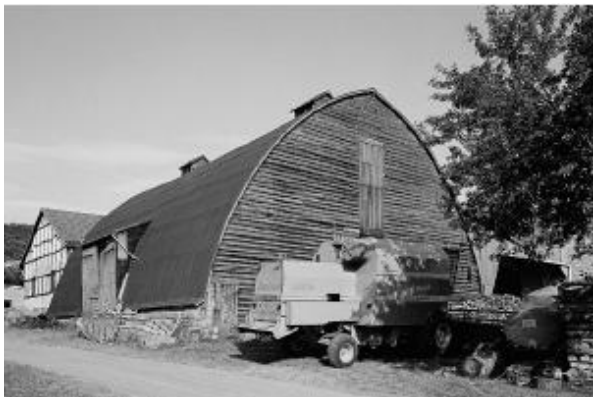
Abb. 30: Feldscheune mit Spitztonnendach in der Dagobertshäuser Straße , Quelle: Denkmaltopografie Stadt Marburg II
