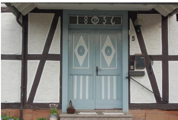
Abb. 164: Zweiflügelige Hauseingangstür; Quelle: Eigene Aufnahme
