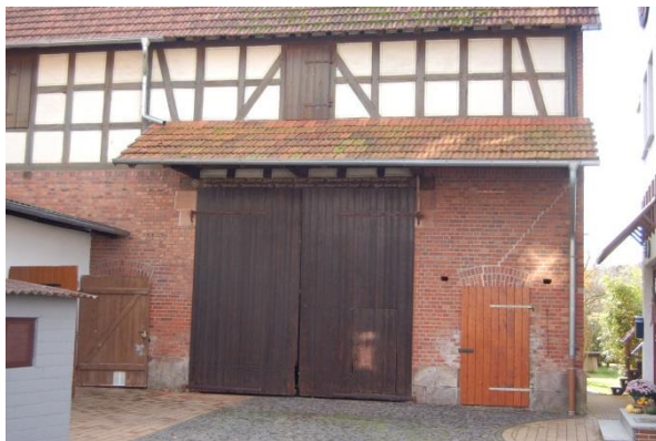
Abb. 158: Vordach über Scheunentor; Quelle: Eigene Aufnahme
