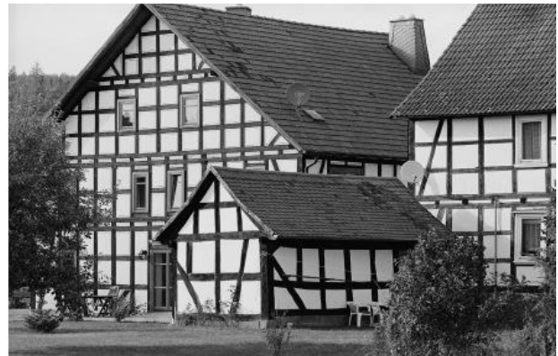
Abb. 11: Südansicht eines Hofes in der Bodenfeldstraße ; Quelle: Denkmaltopografie Stadt Marburg II
