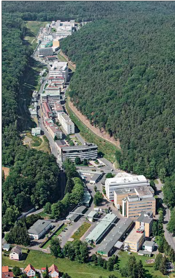
Abbildung 2: Bereiche „Berghof“ und „Hinkelbachtal“ (Pharmaserv GmbH & Co. KG)
