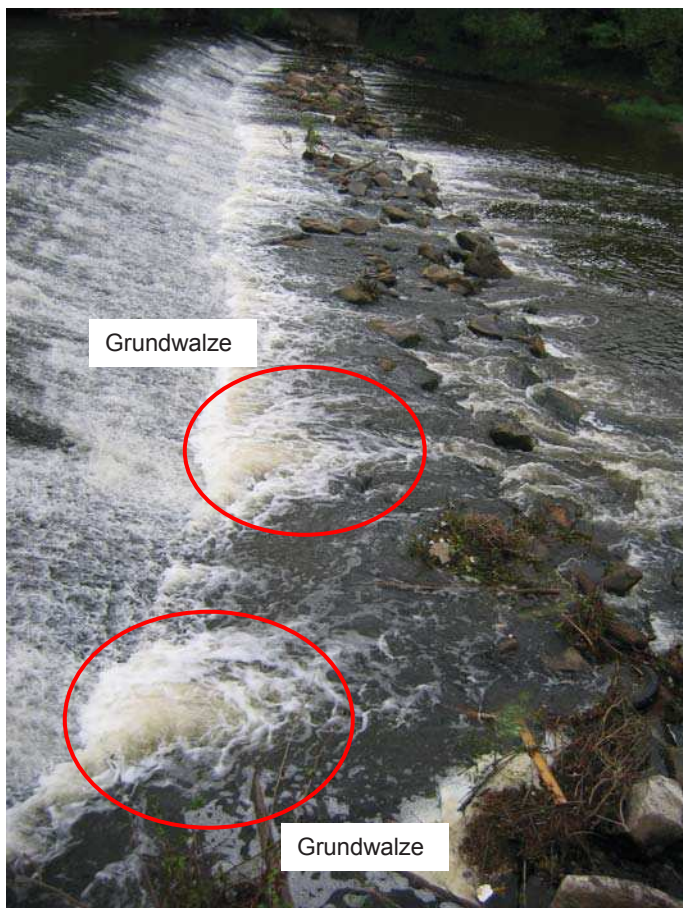
Bild 8: Auskolkungen am Wehrfuß vor der Ölmühle am rechten Lahnufer
