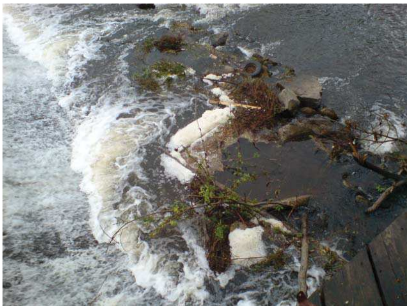
Bild 9: Unrat und Treibgut am Wehrfuß vor der Ölmühle am rechten Lahnufer
