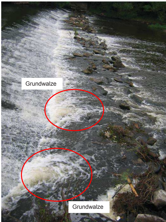
Abbildung 12: Auskolkungen am Wehrfuß vor der Ölmühle am rechten Lahnufer
