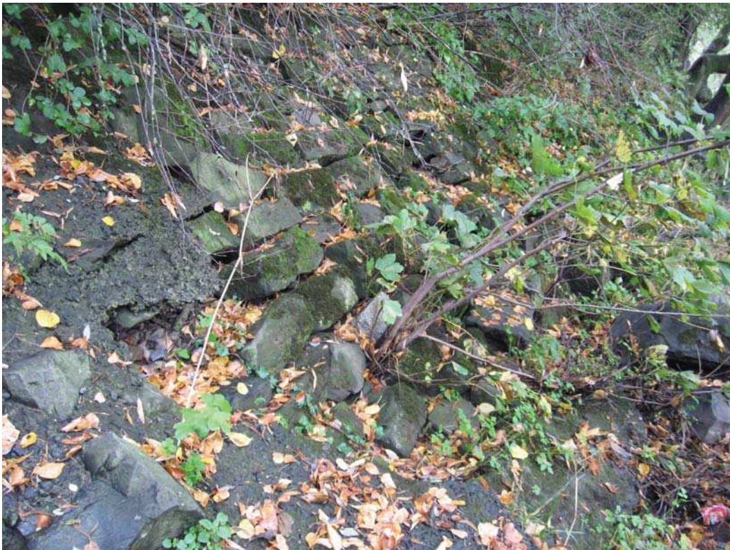
Abbildung 22: Bruchsteinuferbefestigung im Unterwasser am linken Lahnufer
