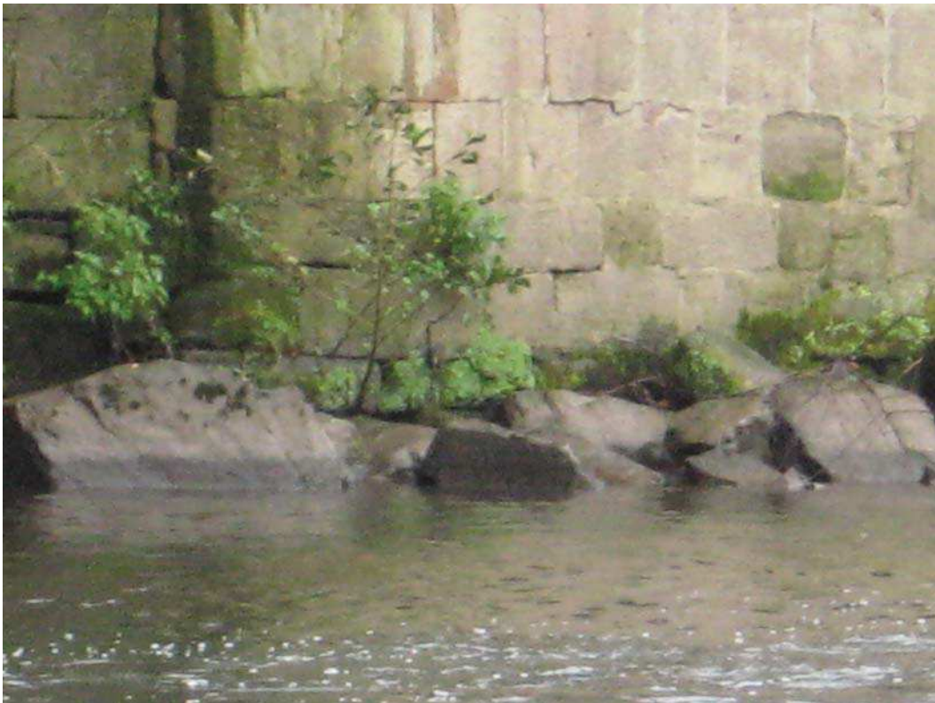
Abbildung 32: Wasserlinie Stützmauer rechts im Unterwasser
