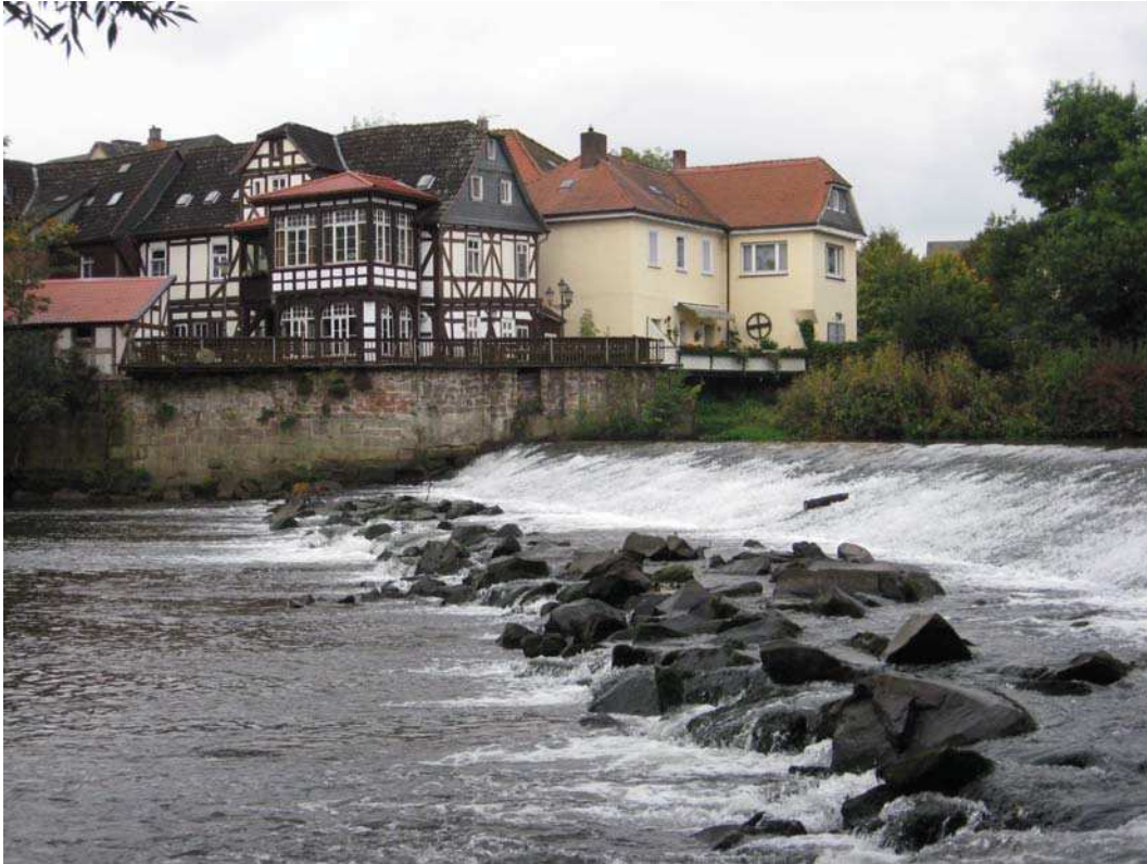
Abbildung 27: Gesamtansicht Stützmauer an der Ölmühle am rechten Lahnufer
