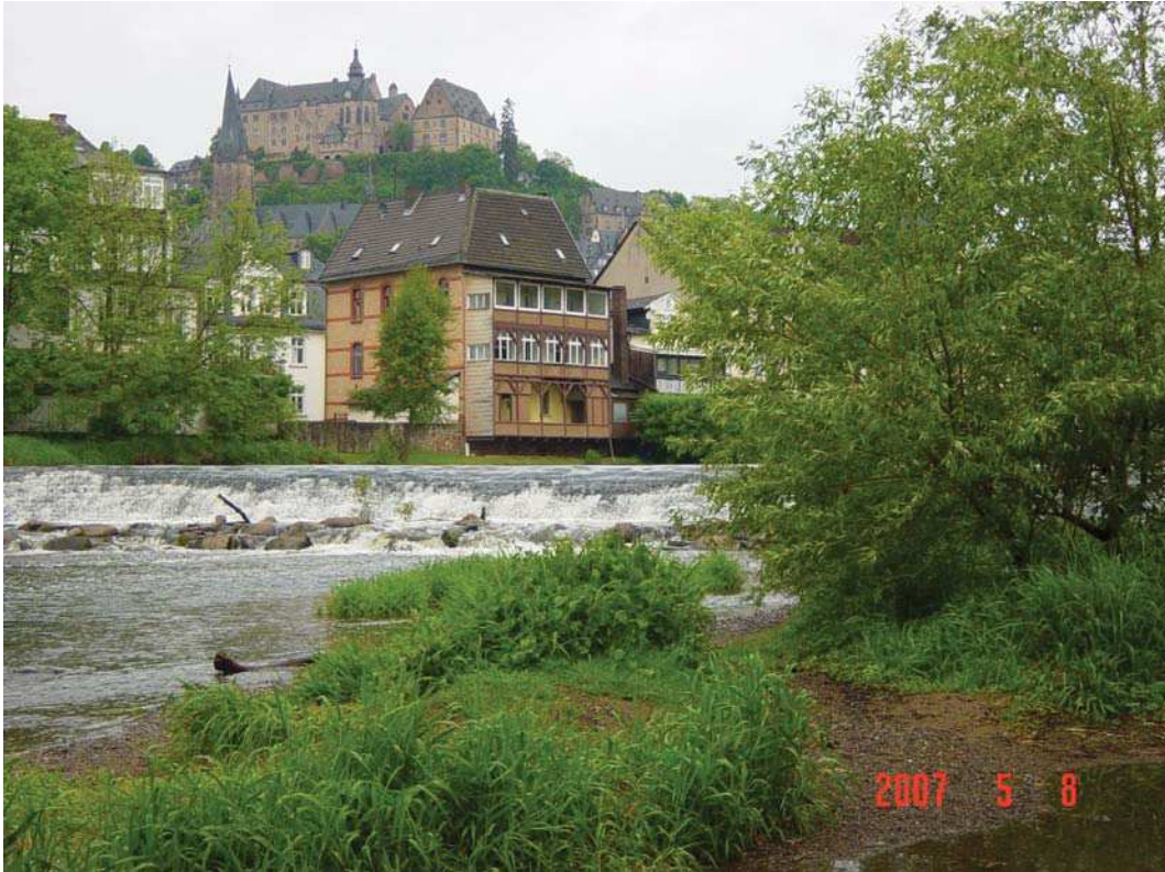
Abbildung 3: Ansicht Unterwasserseite Grüner Wehr und linksseitiges Lahnufer
