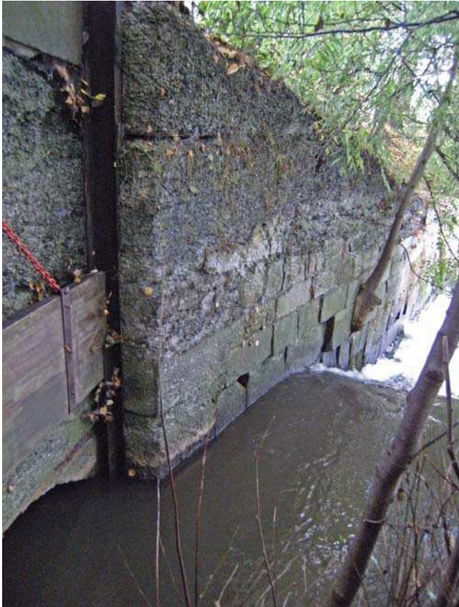
Abbildung 23: Ufermauer im Oberwasser am linken Lahnufer
