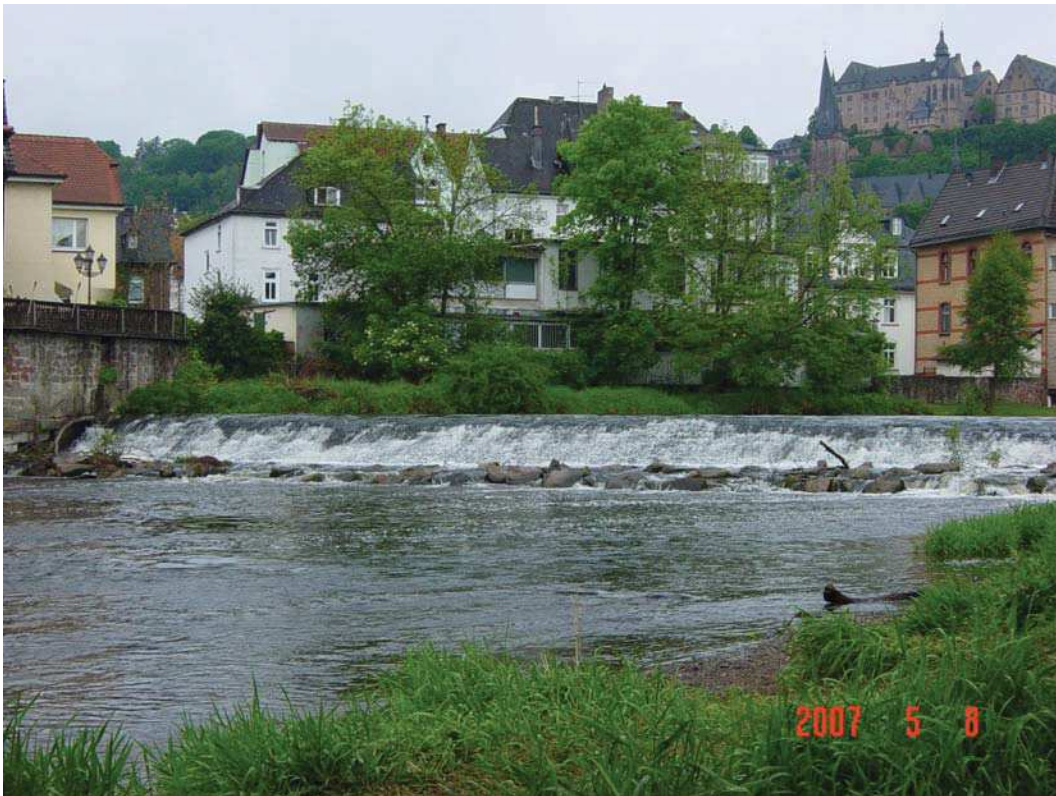
Abbildung 1: Ansicht Grüner Wehr vom linken Lahnufer
