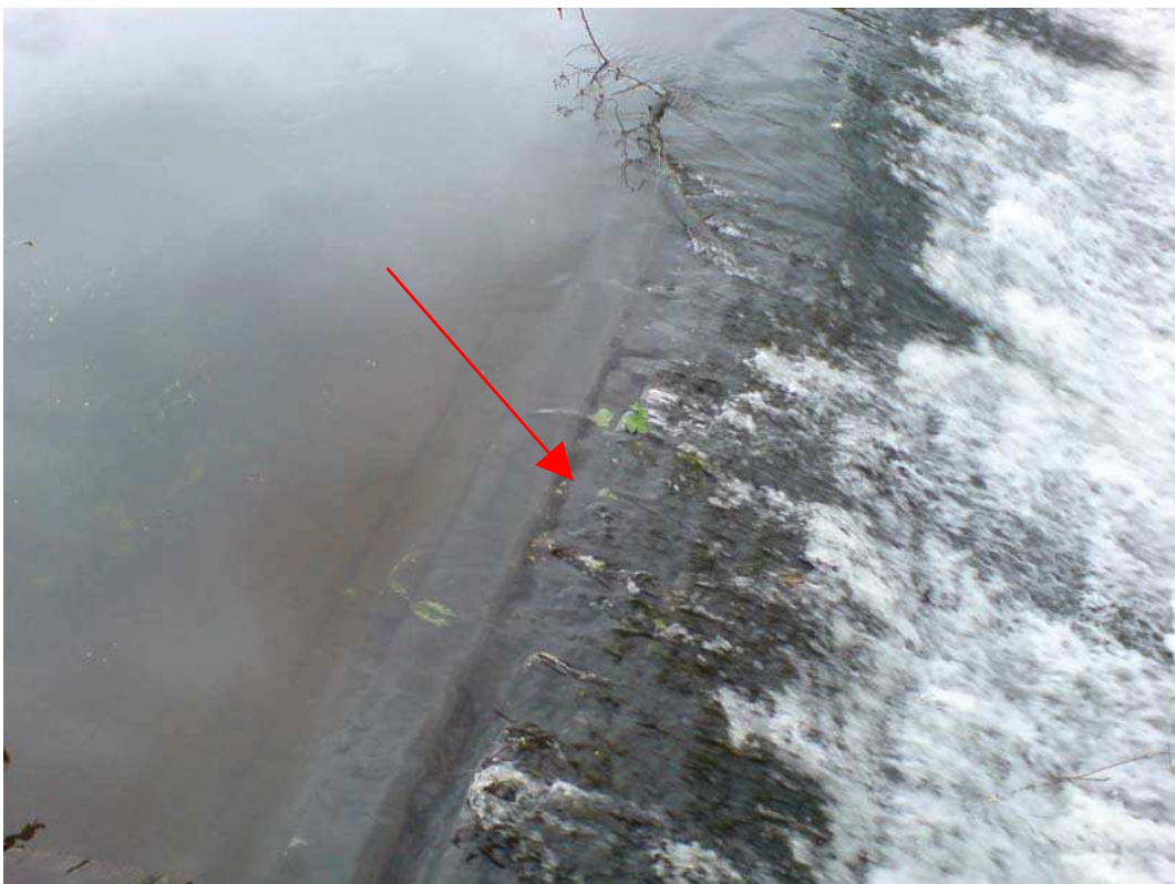
Abbildung 10: Fugen des oberwasserseitigen Deckwerks und Wehrkrone
