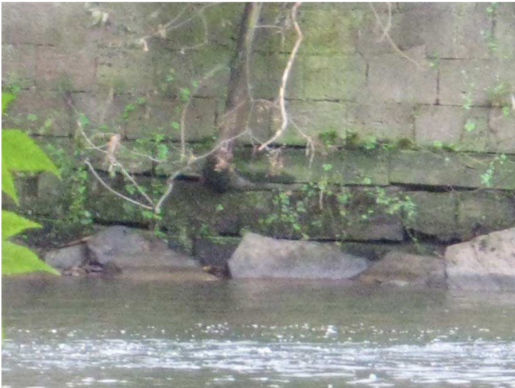
Abbildung 34: Wasserlinie Stützmauer rechts im Unterwasser
