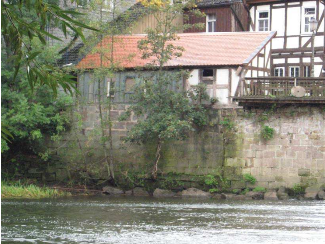
Abbildung 31: Stützmauer an der Ölmühle am rechten Lahnufer
