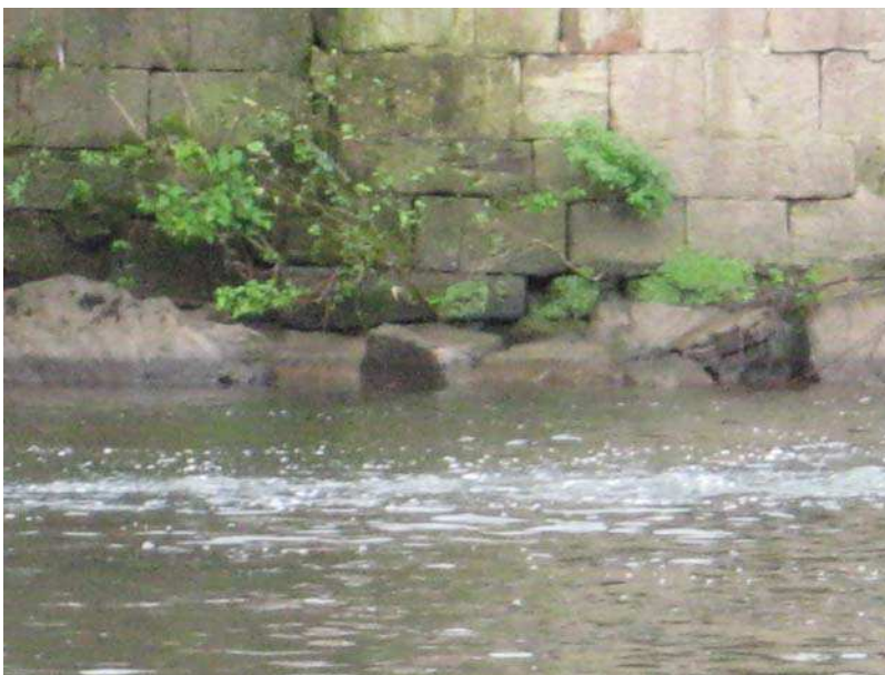
Bild 15: Wasserlinie Stützmauer rechts im Unterwasser
