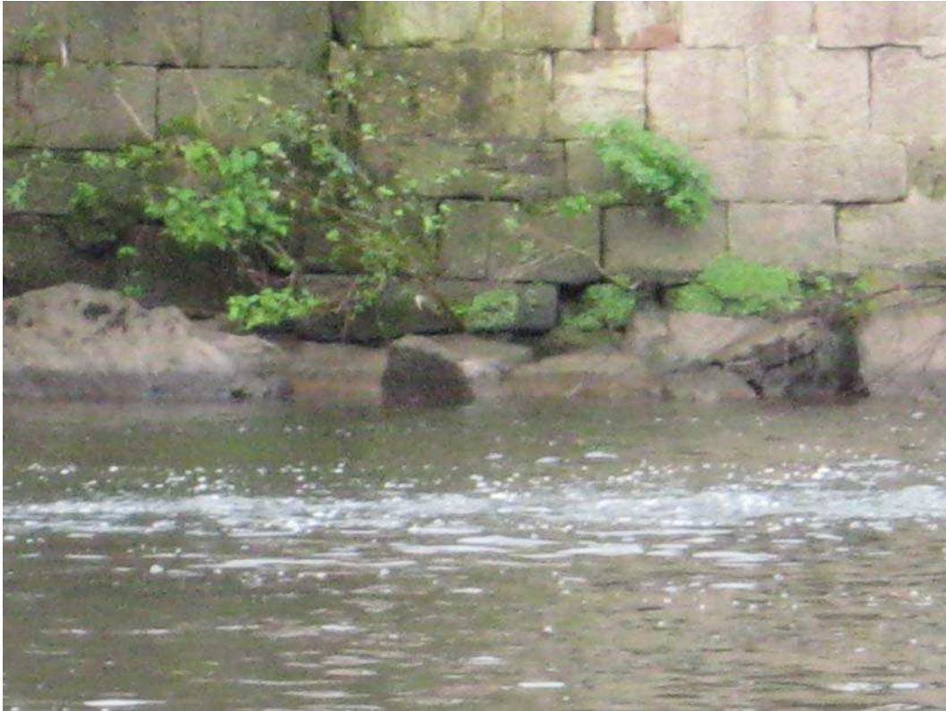
Abbildung 33: Wasserlinie Stützmauer rechts im Unterwasser
