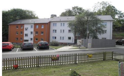
Wohnhäuser „In der Gemoll“ - Nach der Modernisierung
