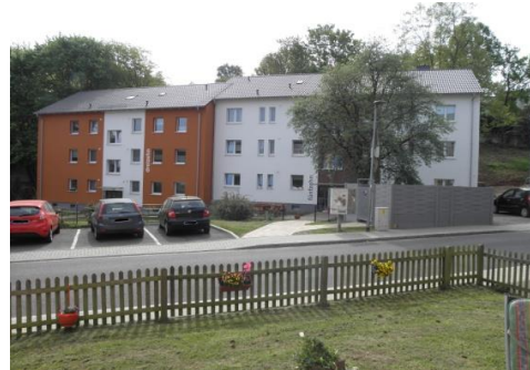
Wohnhäuser "In der Gemoll" - Nach der Sanierung
