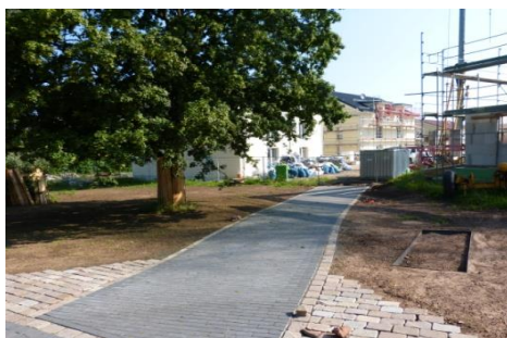
Stadtwaldpark in der Bauphase
