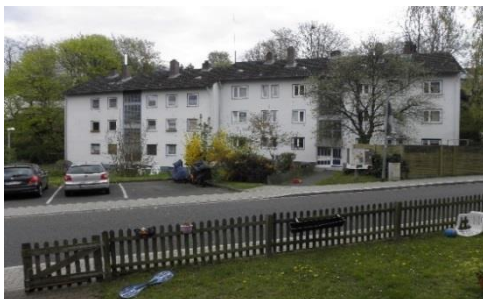
Wohnhäuser „In der Gemoll“ - Vor der Modernisierung
