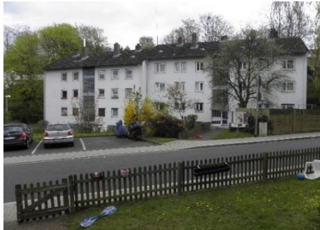
Wohnhäuser "In der Gemoll" - Vor der Sanierung
