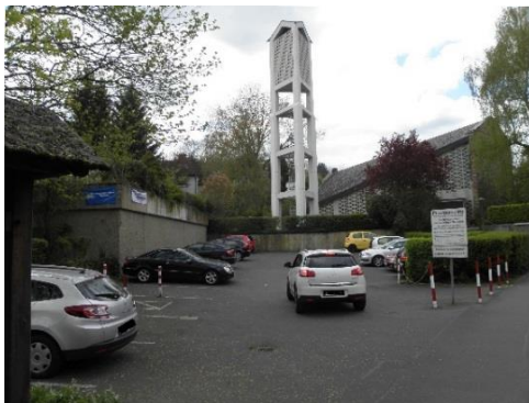
Matthäuskirche mit vorgelagertem Parkplatz
