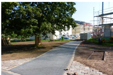
Stadtwaldpark in der Bauphase
