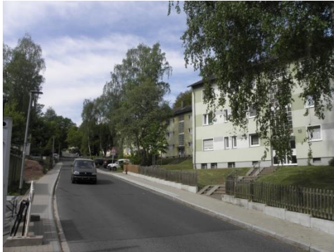
Straßensituation "In der Gemoll"
