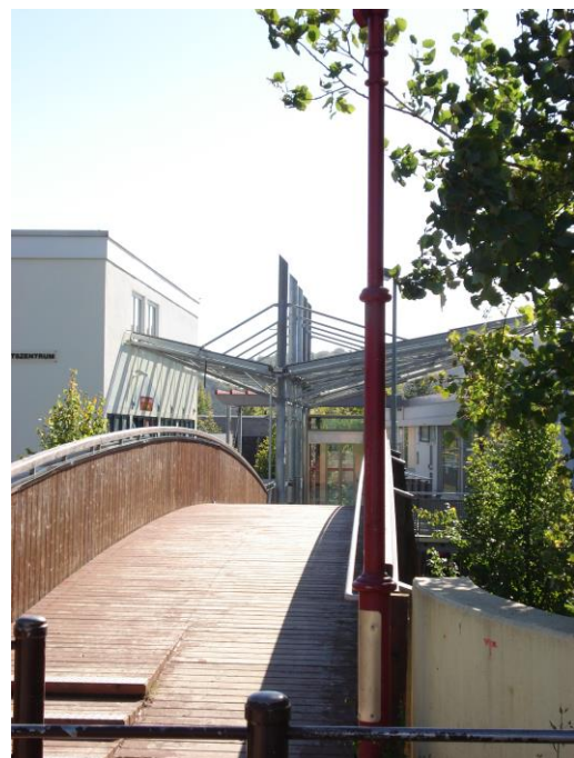
Zugang zum neugestalteten Oberdeck
