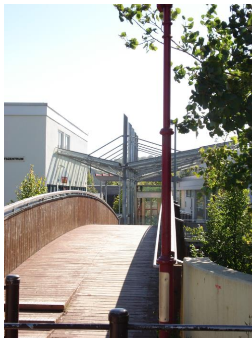
Zugang zum neugestalteten Oberdeck
