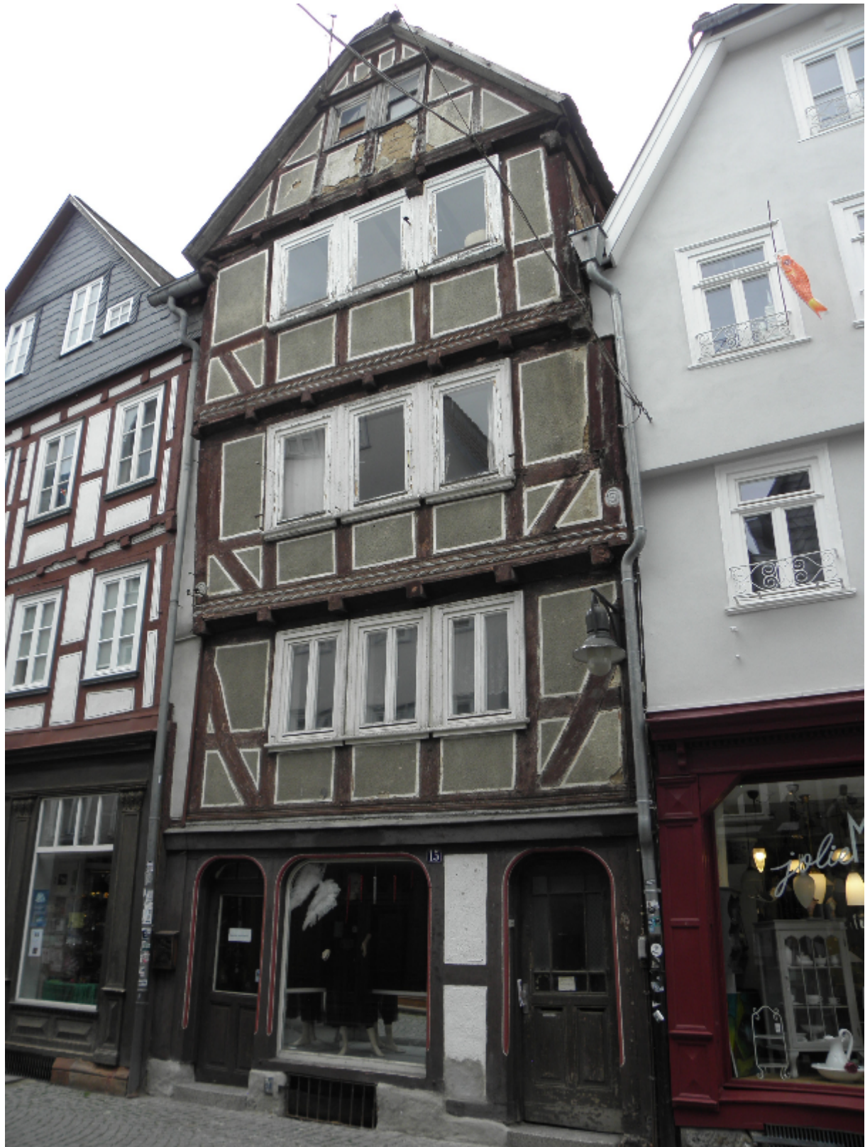
Abb.7: unsaniertes Objekt Barfüßerstr./Leerstand
