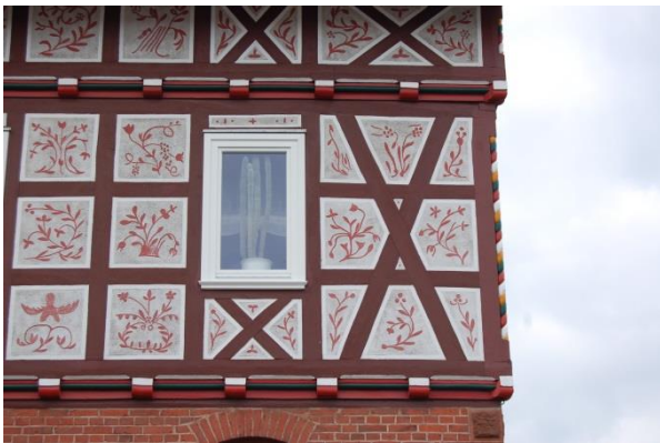
Abb. 103: Detail aus der Kratzputzverzierung des Gebäudes in der Schröcker Straße 9 ; Quelle: Eigene Aufnahme
