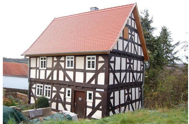
Abb. 44: Saniertes Fachwerkgebäude in der Königstraße 11 (Kulturdenkmal); Quelle: Eigene Aufnahme
