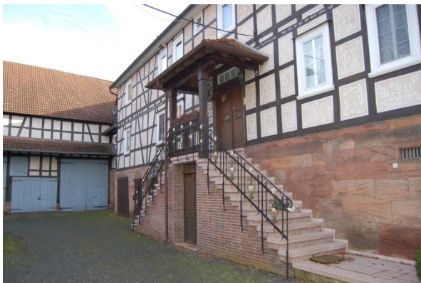
Abb. 157: Vordach über Hauseingang mit zweiläufiger Treppenanlage; Quelle: Eigene Aufnahme
