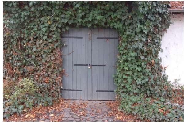
Abb. 162: Eingangstür zu Nebengebäude; Quelle: Eigene Aufnahme
