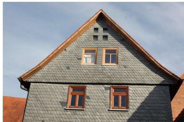
Abb. 142: Schieferung einer Fassade; Quelle: Eigene Aufnahme
