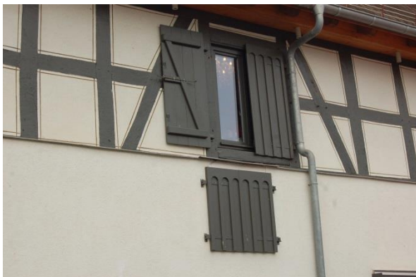
Abb. 153: Fenster mit zweiflügeliger Fensterlade; Quelle: Eigene Aufnahme
