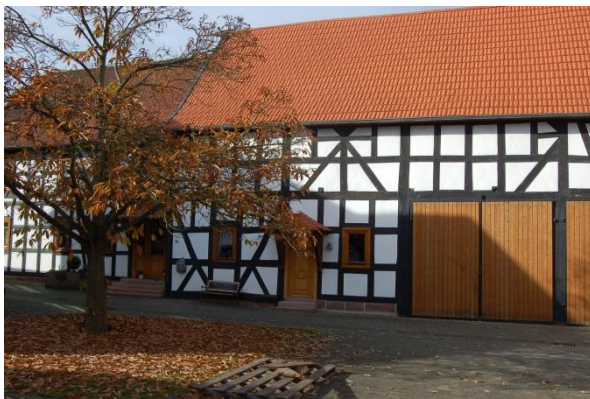
Abb. 131: Dachgestaltung an einer Scheune; Quelle: Eigene Aufnahme
