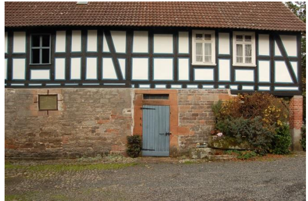
Abb. 31: Sandsteinmauerwerk und Fachwerk an einem Stallgebäude der Hofanlage Im Dorfe 3 ; Quelle: Eigene Aufnahme
