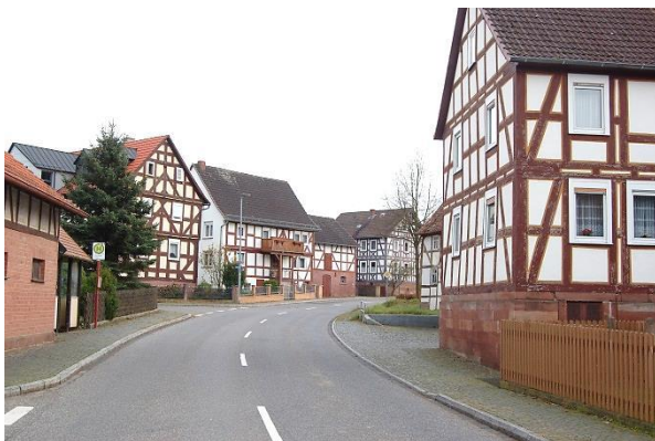
Abb. 47: Blick in den Rinnweg ; Quelle: Eigene Aufnahme
