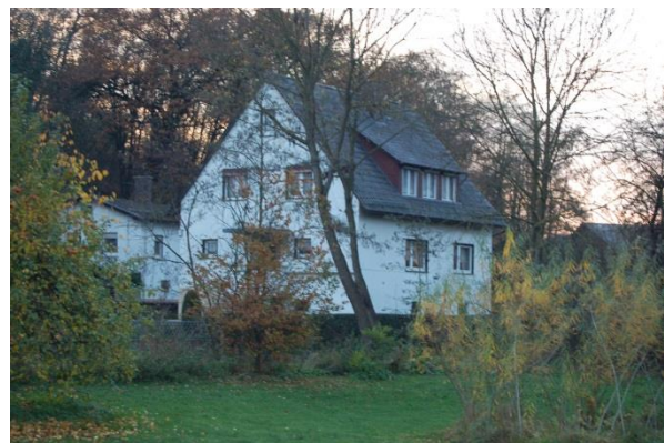
Abb. 138: SchlepPGAube an einem Siedlungshaus der 1950er-Jahre ; Quelle: Eigene Aufnahme
