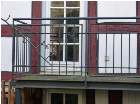
Abb. 166: Balkon in Stahlkonstruktion; Quelle: FD Stadtplanung und Denkmalschutz
