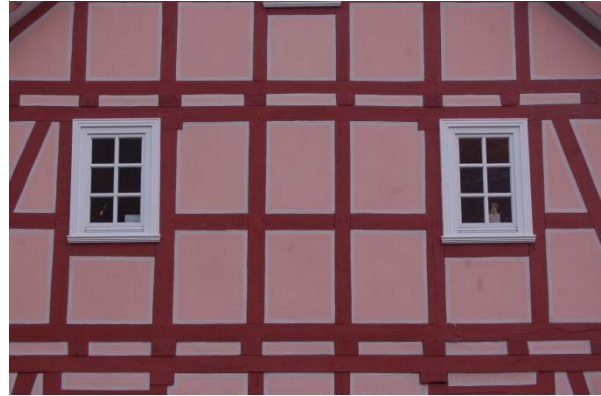
Abb. 112: Detail des Fachwerkgebäudes Kirchgraben 1; Quelle: Eigene Aufnahme
