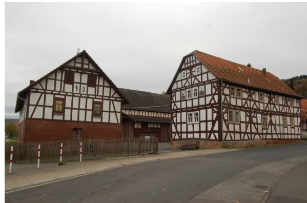
Abb. 58: Denkmalgeschütztes Gehöft in der Dorfmitte 15 ; Quelle: Eigene Aufnahme
