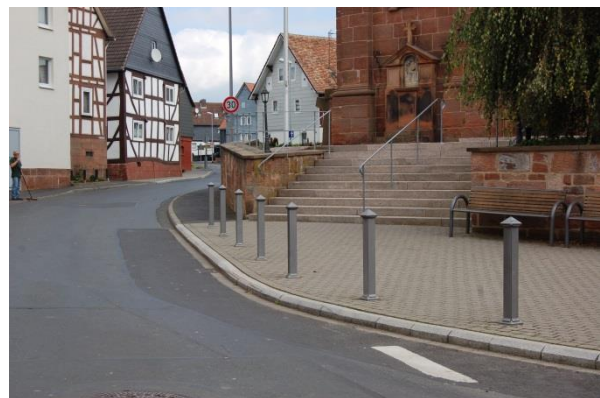
Abb. 100: Blick in die Schröcker Straße nach Norden; Quelle: Eigene Aufnahme
