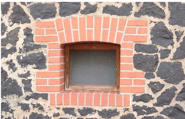
Abb. 14: Gewände eines Kellerfensters in der Bodenfeldstraße ; Quelle: Eigene Aufnahme
