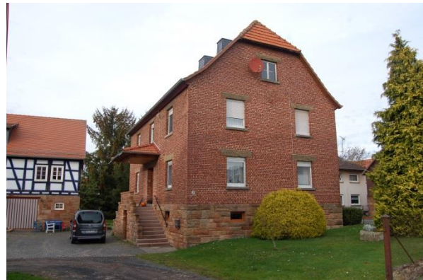
Abb. 130: Krüppelwalmdach am Haupthaus einer Hofanlage; Quelle: Eigene Aufnahme
