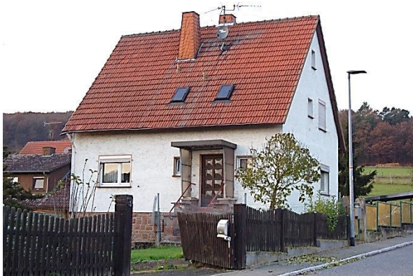
Abb. 76: Siedlungshaus der 1950er-Jahre am Bergring; Quelle: Eigene Aufnahme
