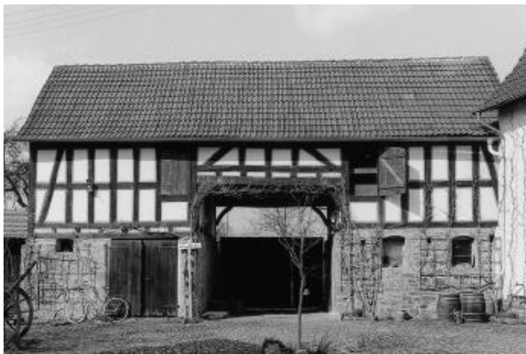
Abb. 16: Toreinfahrt des Hofes Cyriaxstraße 2 ; Quelle: Denkmaltopografie Stadt Marburg II
