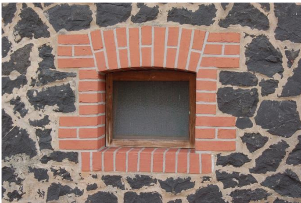
Abb. 145: Basaltsockel mit eingefasstem Fenster mit Ziegeln; Quelle: Eigene Aufnahme
