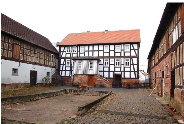
Abb. 79: Vierseithof in der Straße Zum Kalkberg 1 (Hofansicht); Quelle: Eigene Aufnahme
