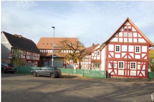
Abb. 125: Dreiseithof in Moischt; Quelle: Denkmaltopografie Stadt Marburg II
