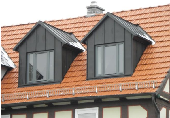
Abb. 135: Giebelgauben an einem modernisierten Fachwerkgebäude; Quelle: FD Stadtplanung und Denkmalschutz
