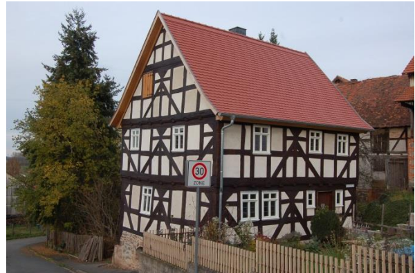
Abb. 126: Einhaus in Einhausen; Quelle: Eigene Aufnahme
