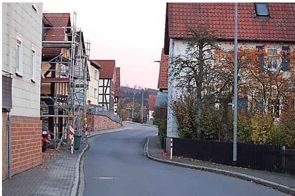
Abb. 62: Blick in die Haddamshäuser Straße von Westen; Quelle: Eigene Aufnahme
