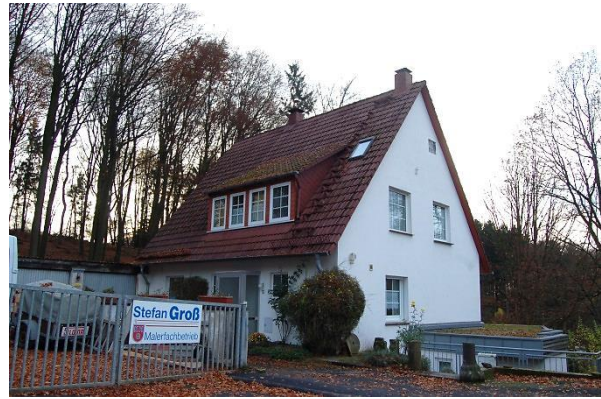
Abb. 114: Siedlungshaus der 1950er-Jahre in der Straße Zur Weinstraße; Quelle: Eigene Aufnahme
