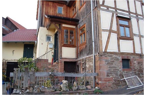
Abb. 75: Fachwerkgebäude mit Sandsteinsockel in der Allnatalstraße; Quelle: Eigene Aufnahme
