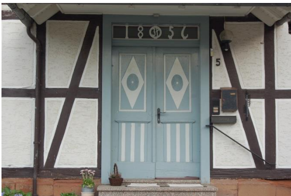
Abb. 164: Zweiflügelige Hauseingangstür; Quelle: Eigene Aufnahme
