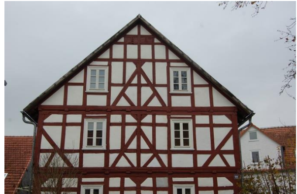
Abb. 19: Detailreiches Fachwerk an der Hofanlage Cyriaxstraße 22 (Ostansicht); Quelle: Eigene Aufnahme
