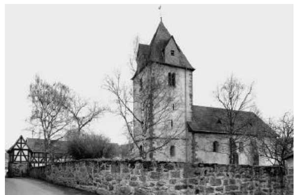
Abb. 80: Evangelische Pfarrkirche; Quelle: Denkmaltopografie Stadt Marburg II
