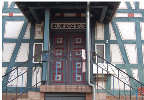
Abb. 165: Kassettenür; Quelle: Eigene Aufnahme
