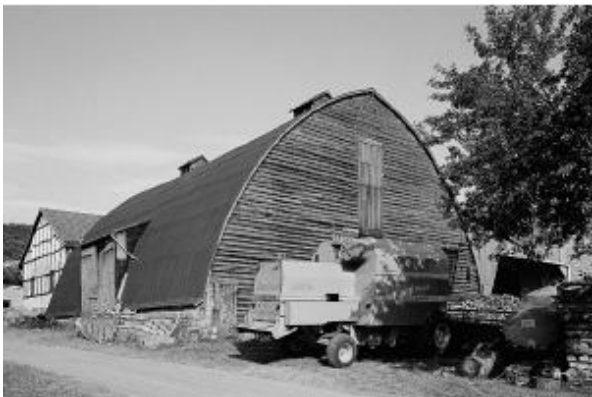
Abb. 30: Feldscheune mit Spitztonnendach in der Dagobertshäuser Straße , Quelle: Denkmaltopografie Stadt Marburg II
