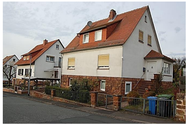
Abb. 84: Siedlungshaus der 1950er-Jahre in der Fliederstraße; Quelle: Eigene Aufnahme
