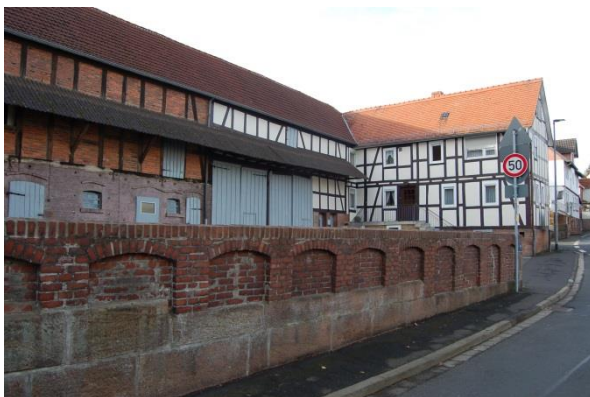
Abb. 174: Einfriedung mit Ziegelmauerwerk; Quelle: Eigene Aufnahme
