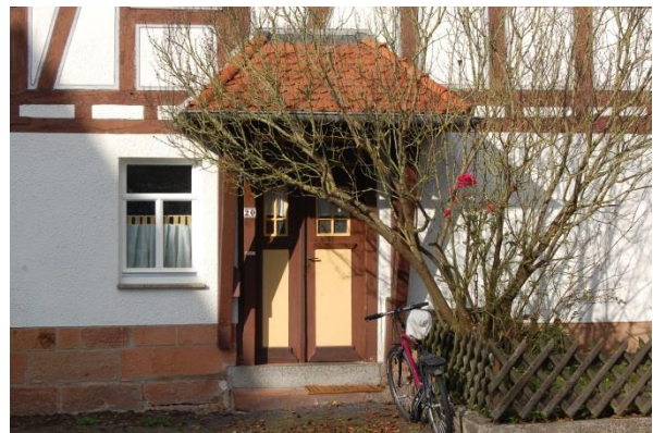
Abb. 158: Walmdach in Holzkonstruktion; Quelle: Eigene Aufnahme
