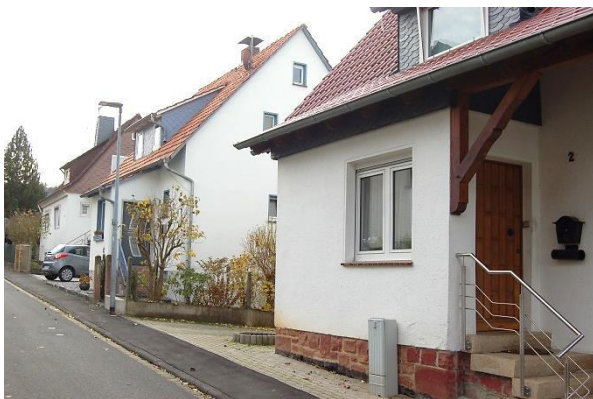
Abb. 53: Siedlungsgebäude der 1950er-Jahre in der Straße Am Schulgarten ; Quelle: Eigene Aufnahme
