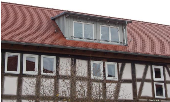
Abb. 137: SchlepPGAube an einem modernisierten Fachwerkgebäude; Quelle: Eigene Aufnahme
