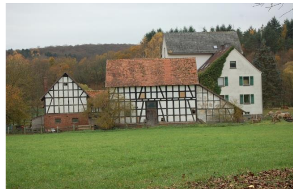
Abb. 117: Haddamshäuser Mühle; Quelle: Eigene Aufnahme
