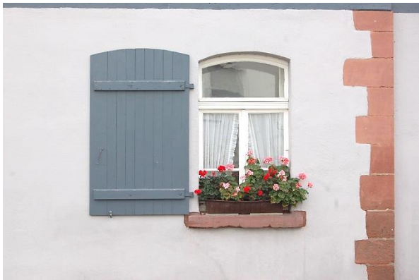
Abb. 51: Fenster des Backhauses in der Bürgelner Straße 1 ; Quelle: Eigene Aufnahme
