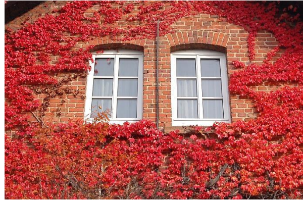
Abb. 98: Begrünung der Fassade des Bürgerhauses (alte Schule); Quelle: Denkmaltopografie Stadt Marburg II
