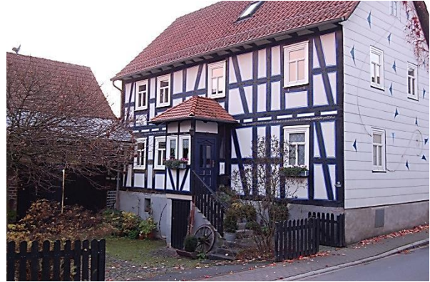
Abb. 67: Farbig angelegte Gefache in der Hofanlage Haddamshäuser Straße 29/31 ; Quelle: Eigene Aufnahme
