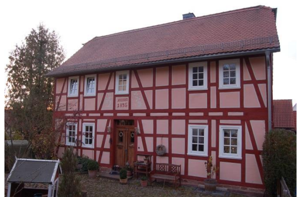
Abb. 148: Farbiges Fachwerk in rot; Quelle: Eigene Aufnahme
