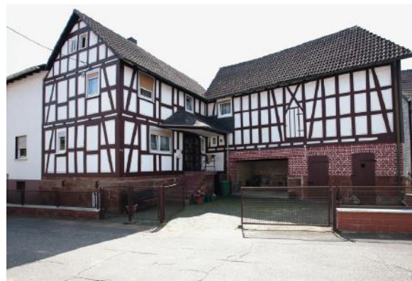
Abb. 96: Hofanlage Im Unterdorf 4 ; Quelle: Denkmaltopografie Stadt Marburg II
