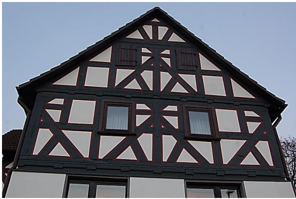
Abb. 68: Fachwerk der Hofanlage Haddamshäuser Straße 36 ; Quelle: Eigene Aufnahme
