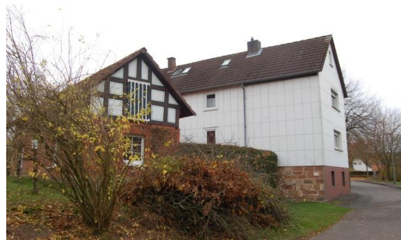
Abb. 120: Mühle in Ronhausen; Quelle: Eigene Aufnahme
