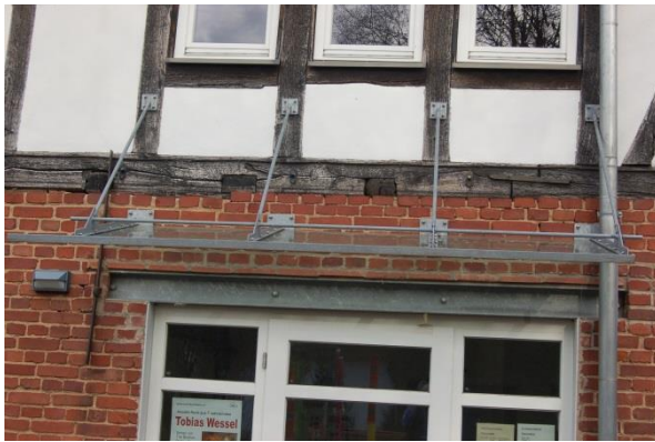
Abb. 161: Zeitgemäße leicht Stahl-Glaskonstruktion; Quelle: Eigene Aufnahme
