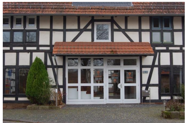
Abb. 160: Neues Vordach über Türelement; Quelle: Eigene Aufnahme
