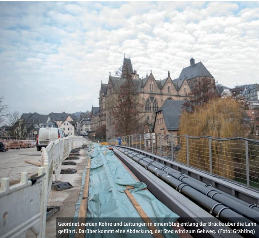
Geordnet werden Rohre und Leitungen in einem Steg entlang der Brücke über die Lahn geführt. Darüber kommt eine Abdeckung, der Steg wird zum Gehweg. (Foto: Grähling)
