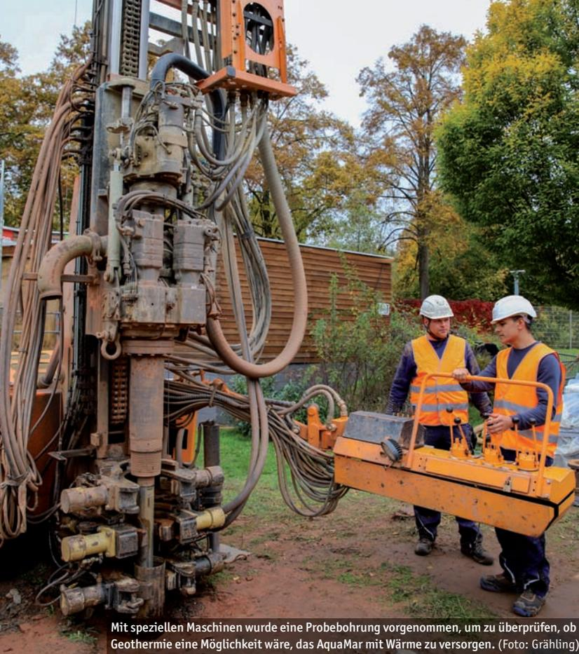
Mit speziellen Maschinen wurde eine Probebohrung vorgenommen, um zu überprüfen, ob Geothermie eine Möglichkeit wäre, das AquaMar mit Wärme zu versorgen. (Foto: Grähling)
