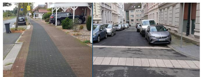
Um eine niveaugleiche Gehwegführung an Zufahrten (links) und in Nebenstraßen (rechts) zu ermöglichen, sollen Bordsteine mit abgeschrägten Flächen am Rand (sogenannte Fasen) verwendet werden
