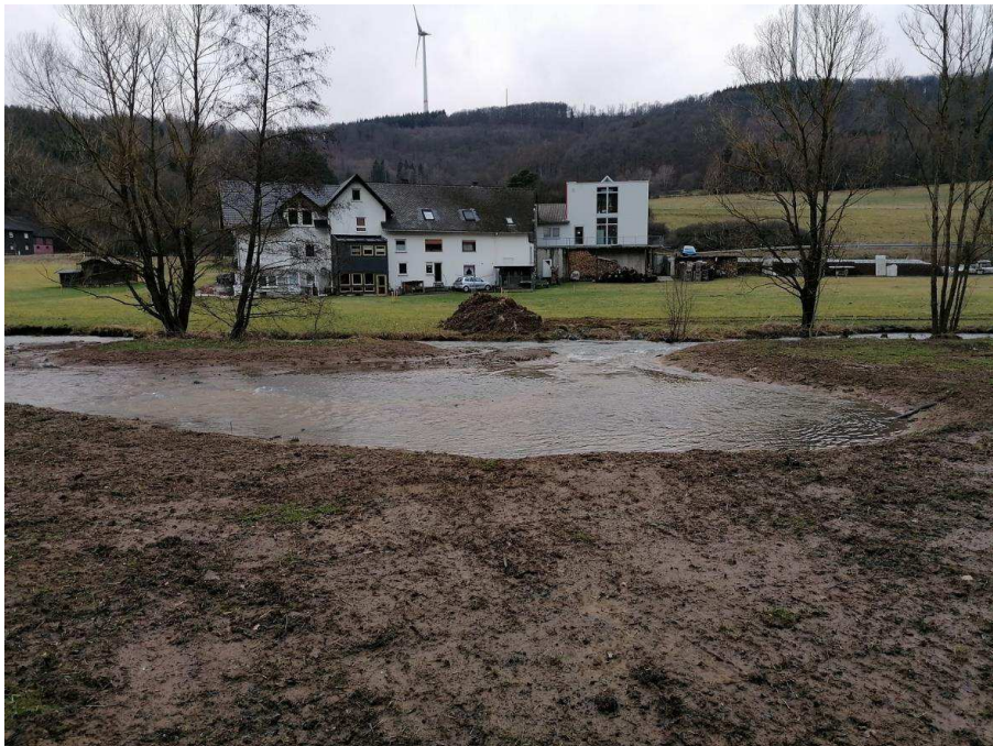
Retentionsmulde bei erhöhten Abflüssen
