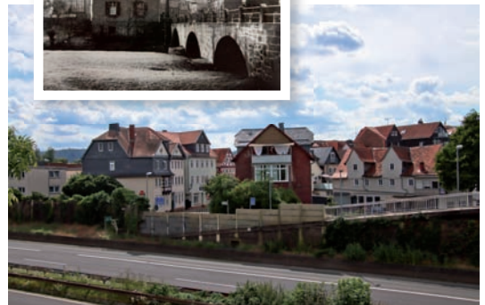
Das Foto der Erlengrabenbrücke mit Torhaus entstand um 1920. Heute ist der Anblick deutlich weniger romantisch. (Fotos: Kieselbach/Foto Marburg)
