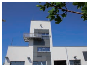
Feuerwehr Cappel Neubau
