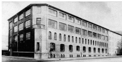
Nach dem Wiederaufbau (L.) wurde das Werksgebäude Ecke Mauerstraße/Cölber Straße (heute Ernst-Giller-Straße) zunächst zur Schraubenfabrik. Vor dem Krieg war hier die Marburger Tapetenfabrik ansässig. (Fotos: Kieselbach/HSF)
