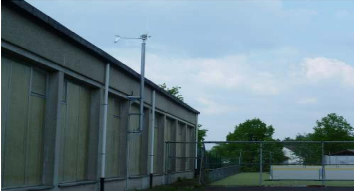
Abb. 34: Kleinwindrad mit horizontaler Drehachse an der Turnhalle der Erich-Kästner-Schule (2010)
