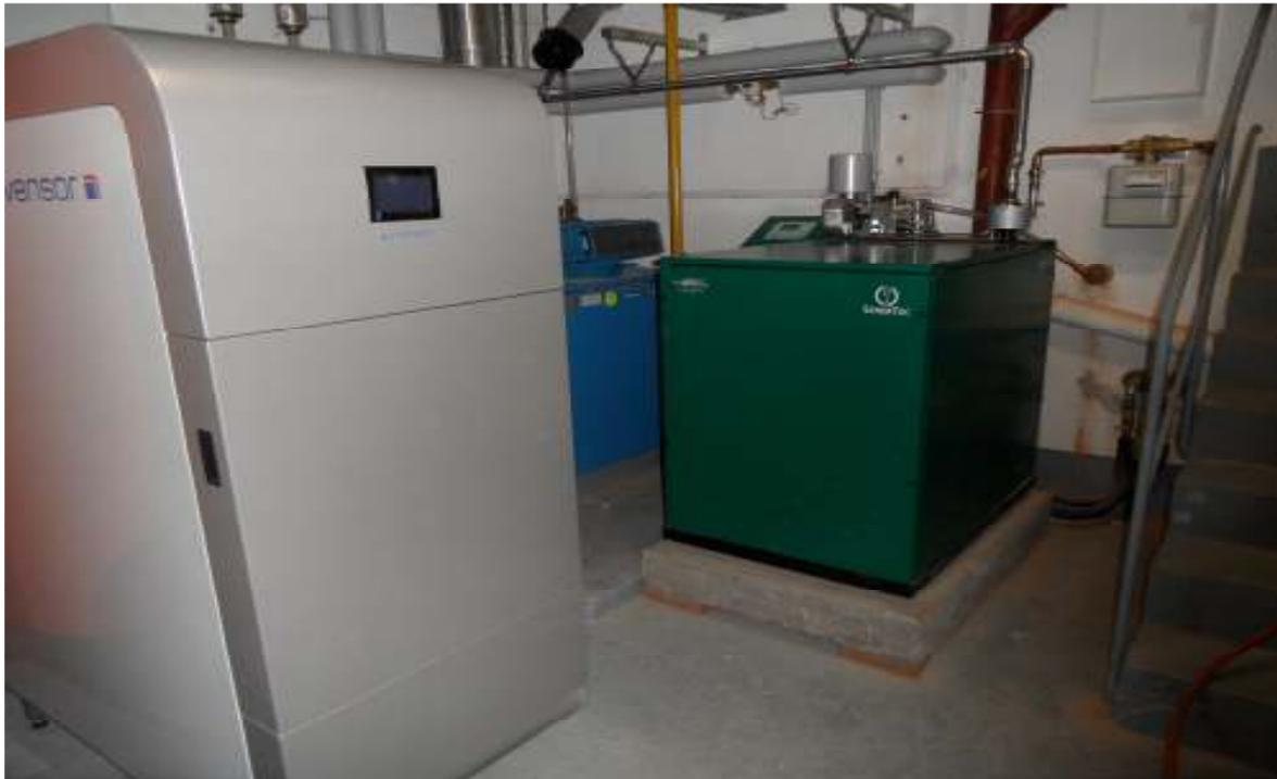
Abb. 40: Links im Bild die Adsorptionskältemaschine, rechts das Mini-BHKW
