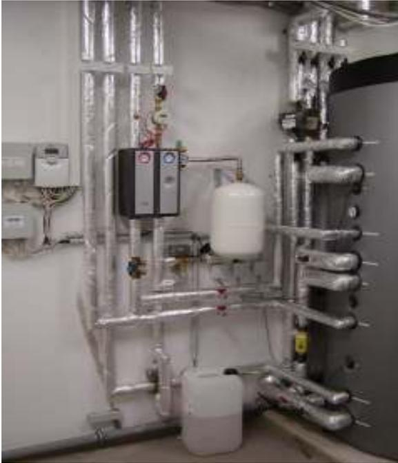
Abb. 31: Pufferspeicher mit allen Anschlüssen
