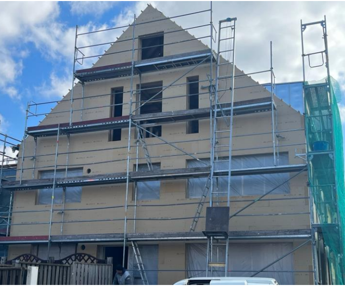
Dämmung Fassade mit IsoFloc und Holzfaser
