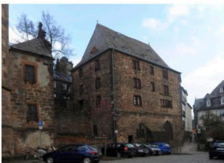
Der Kerner: das dreigeschossige Bauwerk aus Sandsteinmauerwerk hat ein Sockelgeschoss mit zweigeschichtigem Gewölbe zum Lutherschen Kirchhof
