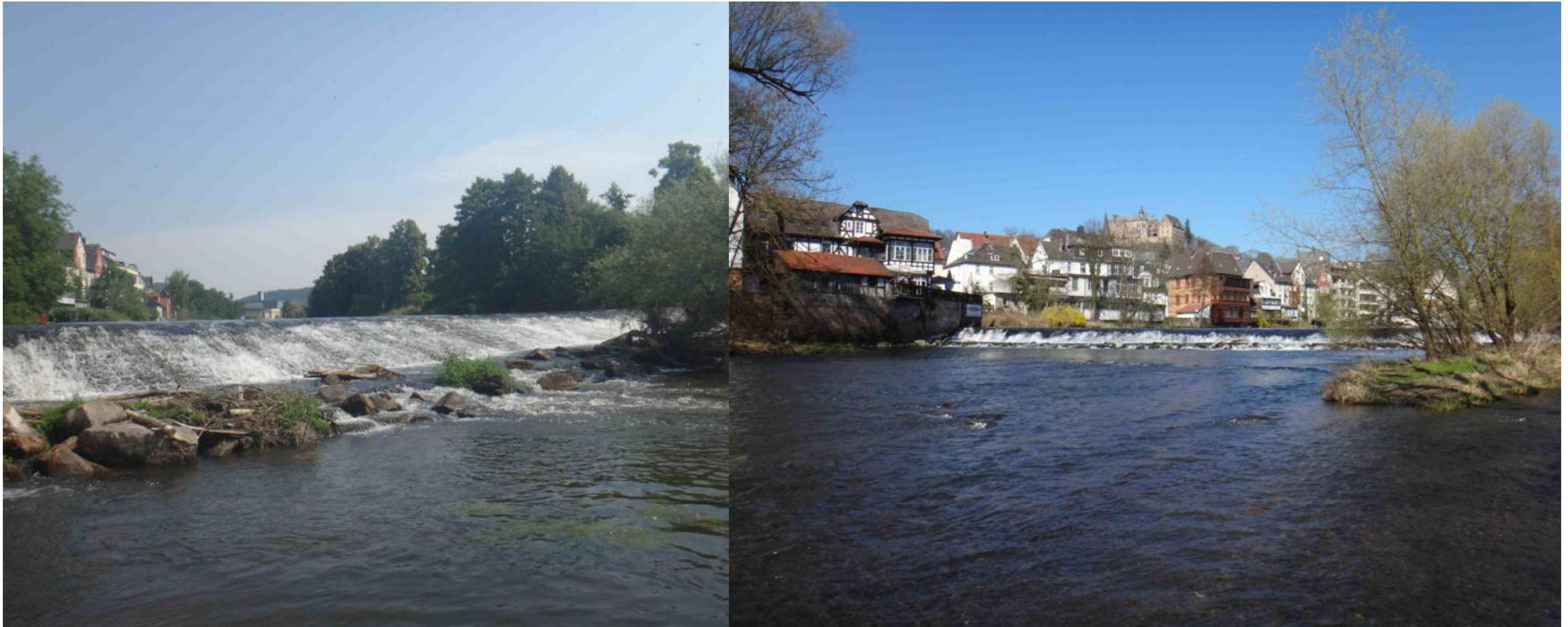
Permanenter Abfluss über die Wehrkrone auch bei Niedrigwasser →
