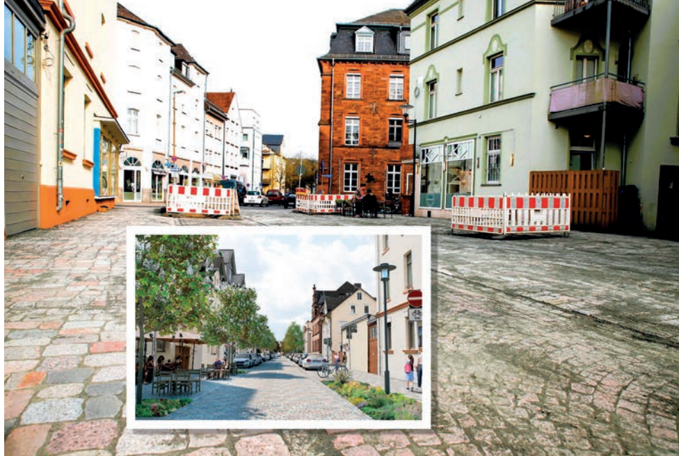
Der erste Bauabschnitt ist fertig, jetzt wird aus Richtung Gutenbergstraße weiter saniert. Entstehen wird nach Abschluss aller Arbeiten ein Ort, der künftig auch besseren Schutz gegen Hitze bietet. Die Orte für Pflanzen und Bäume sind bereits angelegt (Baken). (Foto/Grafik: Stadt/Grähling)
