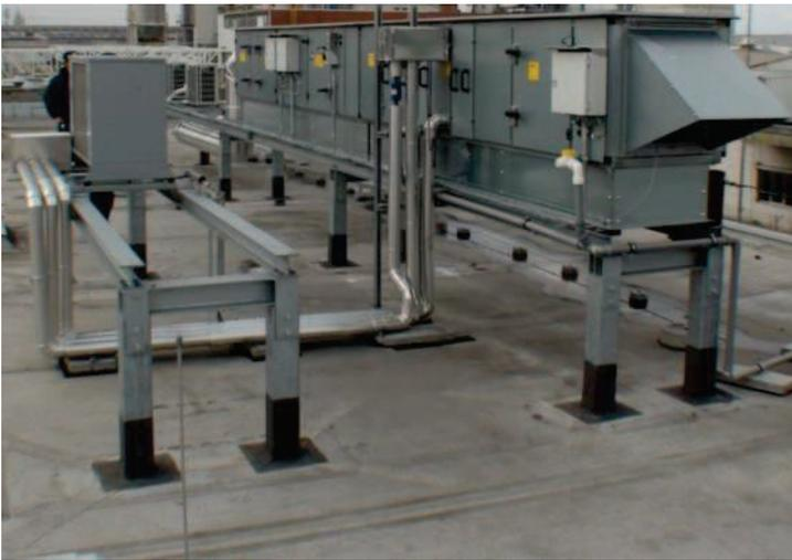
Abbildung 4-10: Lüftungsanlage ohne Wärmerückgewinnung
