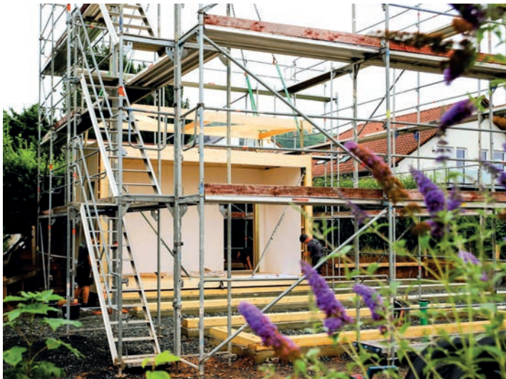
In der Grundschule Michelbach (Bild) und in Elnhausen wurde im Sommer für zusätzlichen Unterrichtsraum gebaut – in nachhaltiger Holzmodulbauweise. (Foto: Schmidt)
